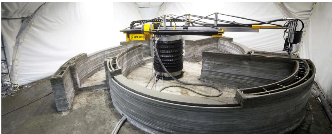
Obrázek 27 - Tiskárna firmy Apis Cor při tisku
