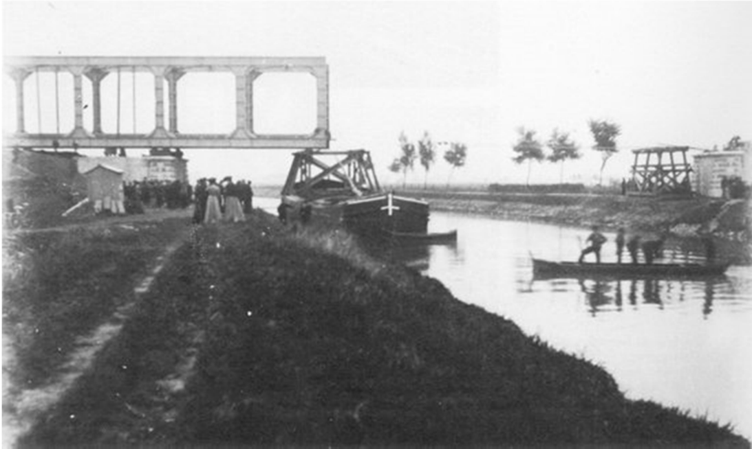
Obrázek 5 – Stavba prvního mostu dle návrhu Arthura Vierendeela ve městě Aalst
