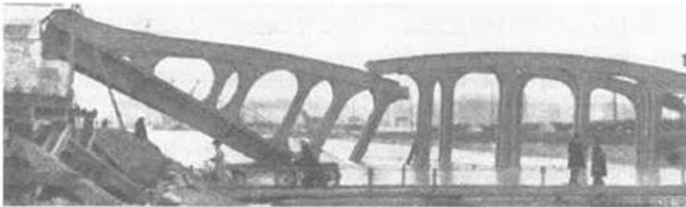
Fig. 5.1 The collapse in March 1938 of the Hasselt Road Bridge over the Albert Canal in Belgium. (Stálbygge. Utdrag ur Stálbyggnad, programskrift I I)
