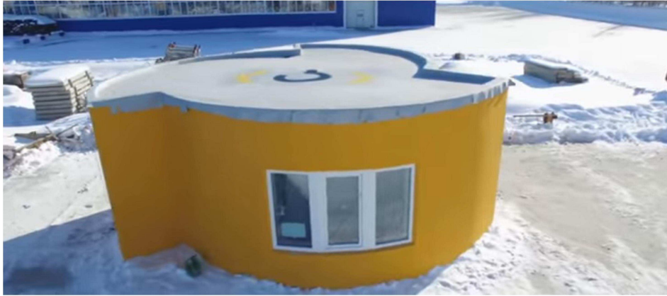
Obrázek 28 - Vytisknutý dům tiskárnou firmy Apis Cor
