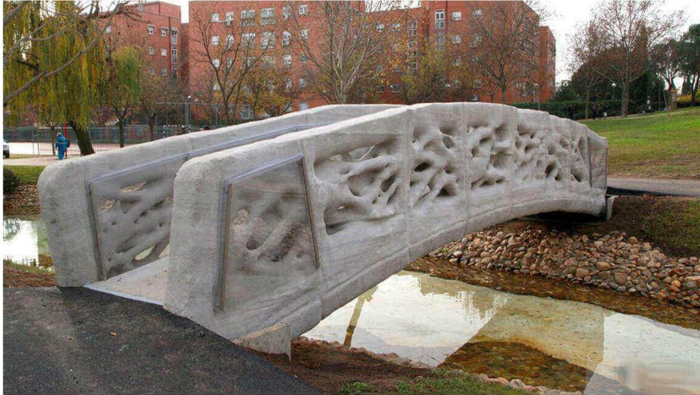
Obrázek 25 – Most pro pěší v Madridu vytištěný pomocí technologie D-Shape
