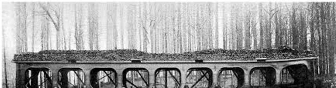
Obrázek 4 - Zátěžový test prototypu Vierendeelova mostu ve městě Tervueren
