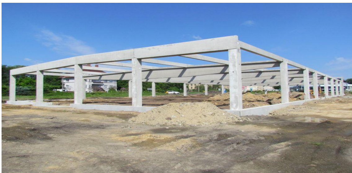
Obrázek 3: Ukázka železobetonového skeletu montované haly [7]
