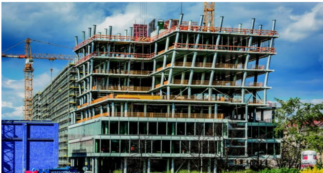
Obrázek 2: Ocelové konstrukce ČIIRK – objekt A [5]
