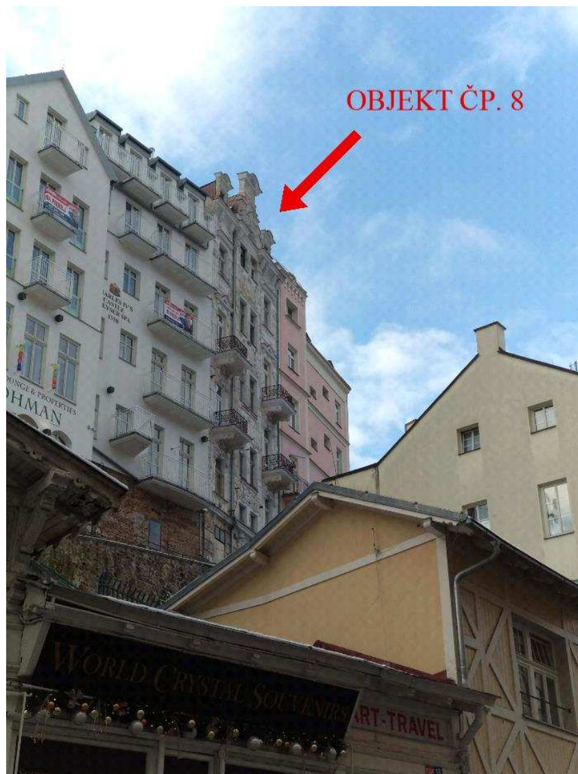
Obrázek 25 Pohled na objekt čp. 8 z Lázeňské kolonády
