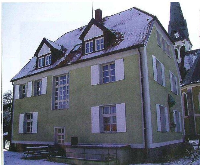
Obrázek 21 Obnova fary v Liberci Ruprechticích po dokončení [33]
