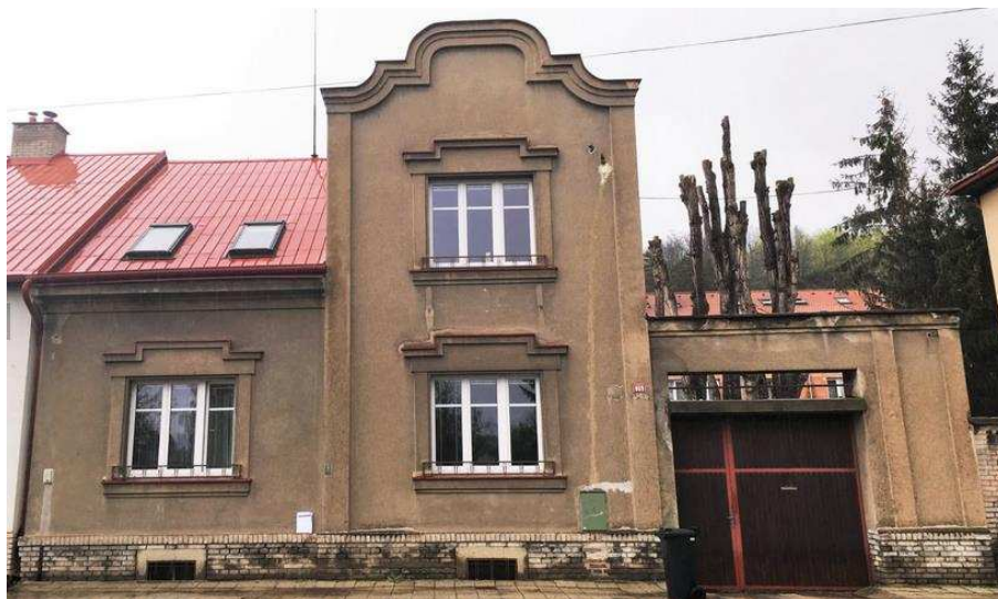
Obrázek 8 Stav objektu v Kralupech nad Vltavou před aplikací kontaktní tepelné izolace
