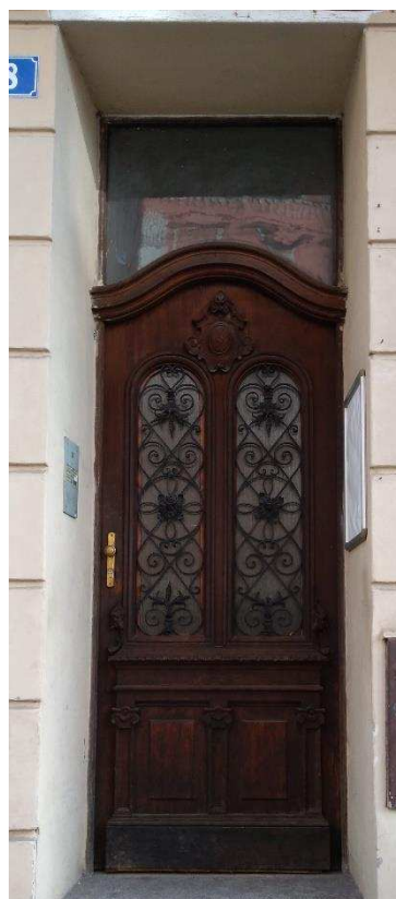
Obrázek 73 Původní vstupní dveře do objektu D02
