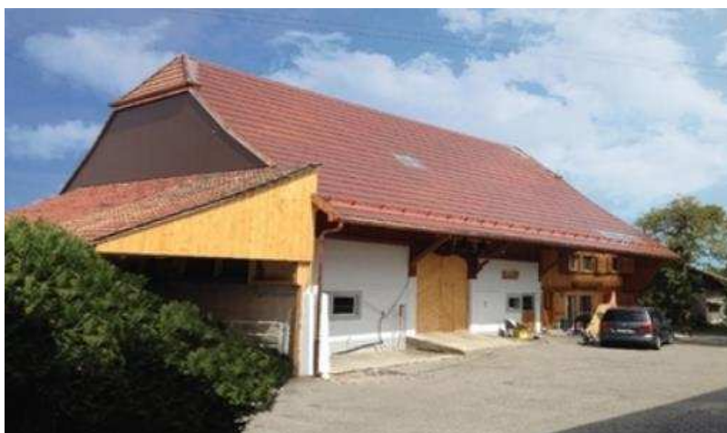
Obrázek 20 Fotovoltaické tašky aplikované na vesnickém objektu ve Švýcarsku [32]
