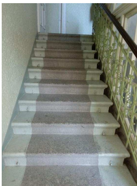
Obrázek 30 Rameno schodiště v běžném nadzemním podlaží objektu čp. 8
