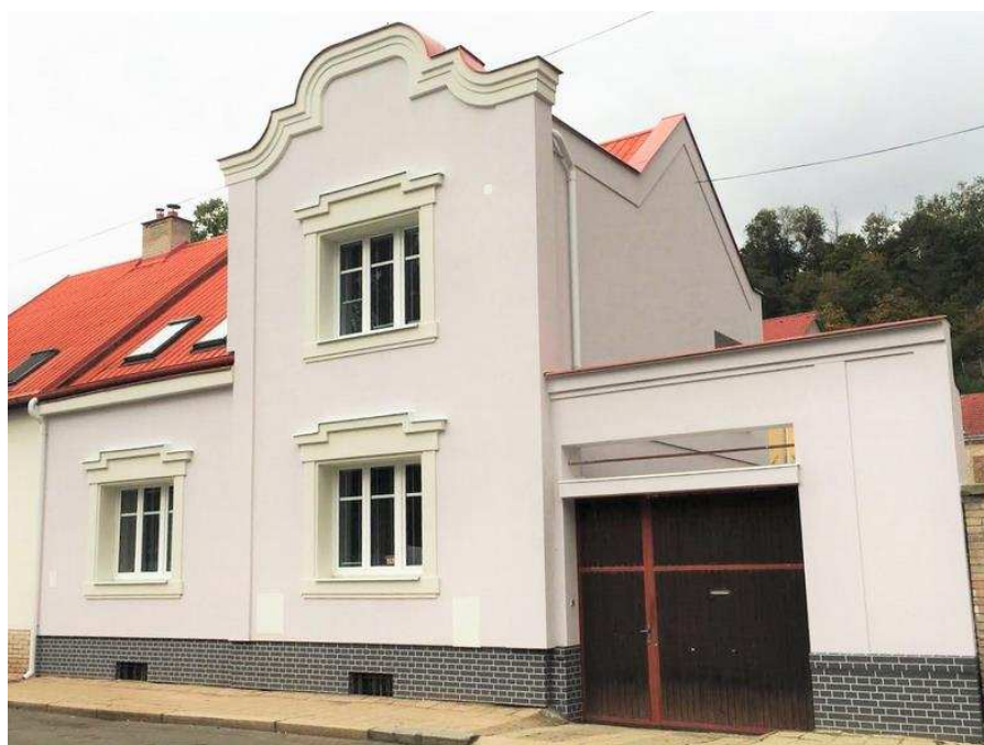
Obrázek 9 Stav objektu v Kralupech nad Vltavou po aplikaci kontaktní tepelné izolace a fasádní omítky [14]
