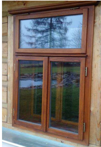
Obrázek 16 Příklad kastlového dřevěného okenního otvoru [26]
