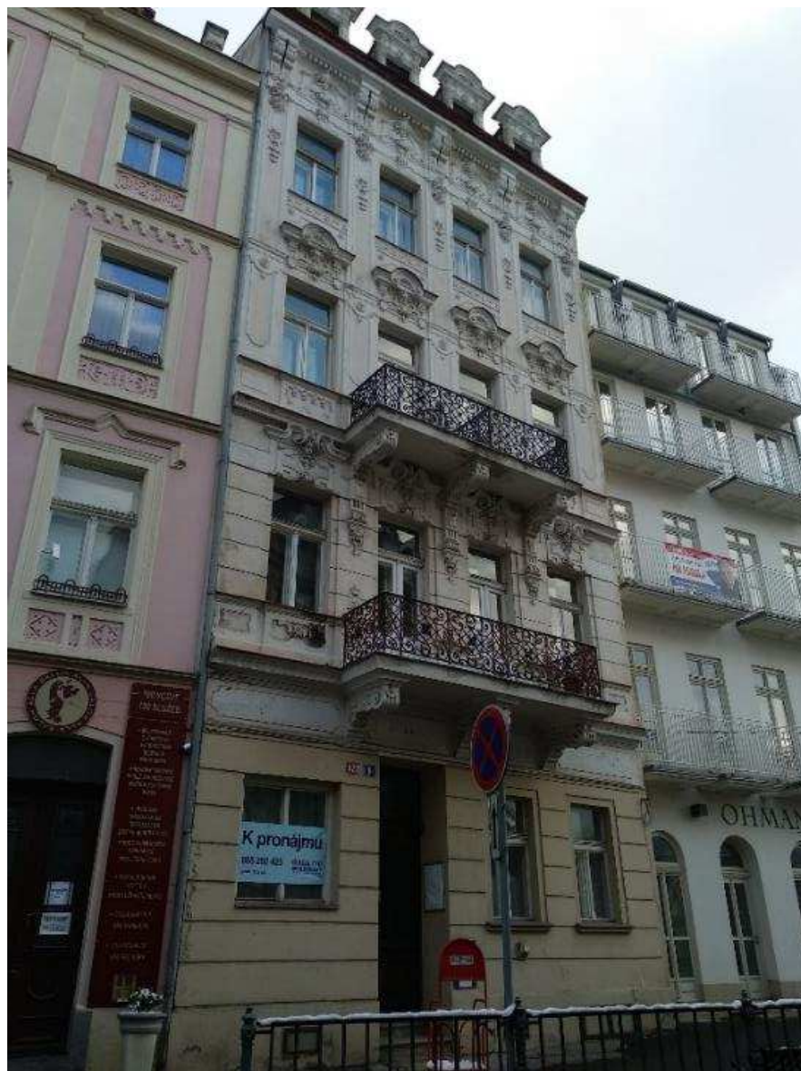
Obrázek 26 Pohled na objekt čp. 8 ze Zámecké kolonády
