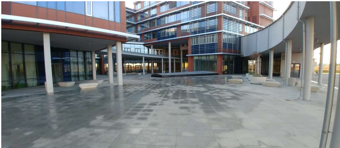
Obrázek 18: Fotografie atria na severní straně budovy, Zdroj: Autor
