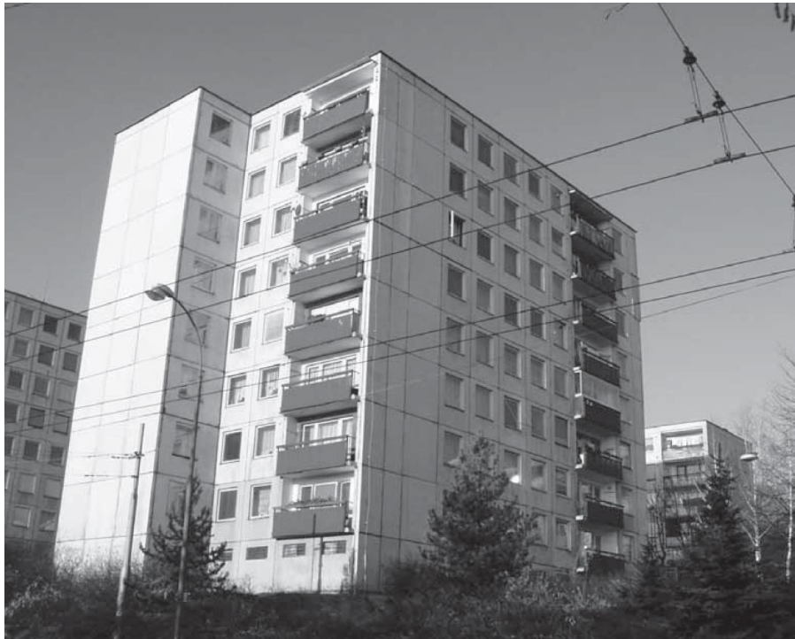
Obrázek 5: Fasáda bytového domu panelové soustavy B 70 Zdroj: [2, str. 17]
