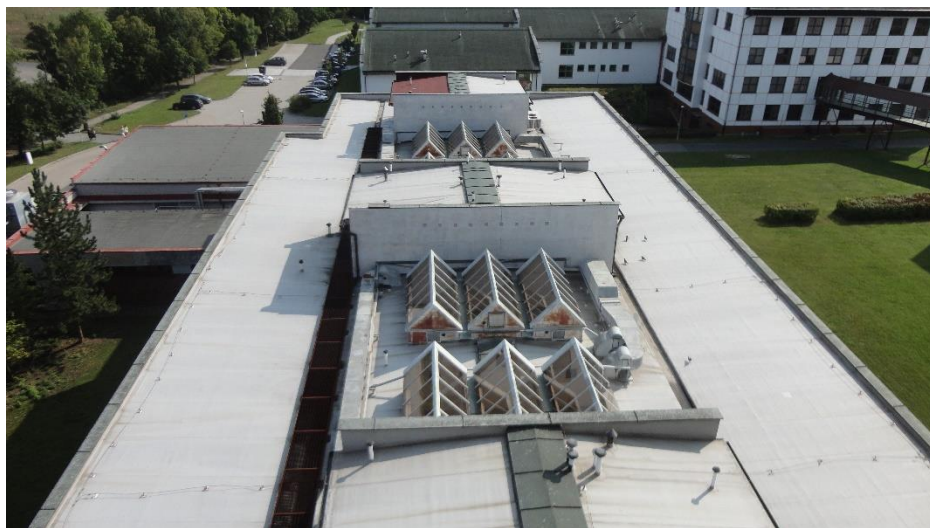
Obrázek 69: Pohled na střechu učebnového pavilonu Zdroj: Autor
