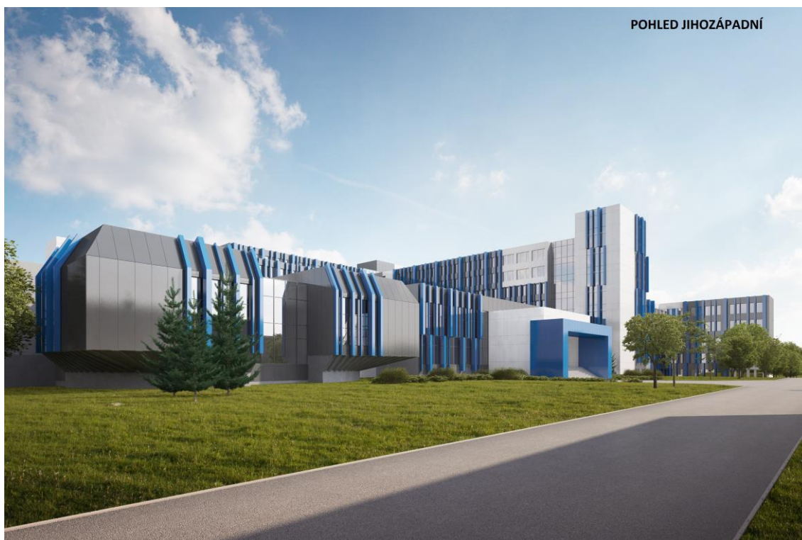
Obrázek 98: Pohled jihozápadní-Fakulta strojní Autor: Ing. arch. Pavel Němeček, CSc., Ing. arch. Daniel Němeček
