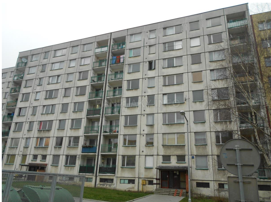
Obrázek 6: Průčelí domu OP 1.11 Zdroj: [4]
