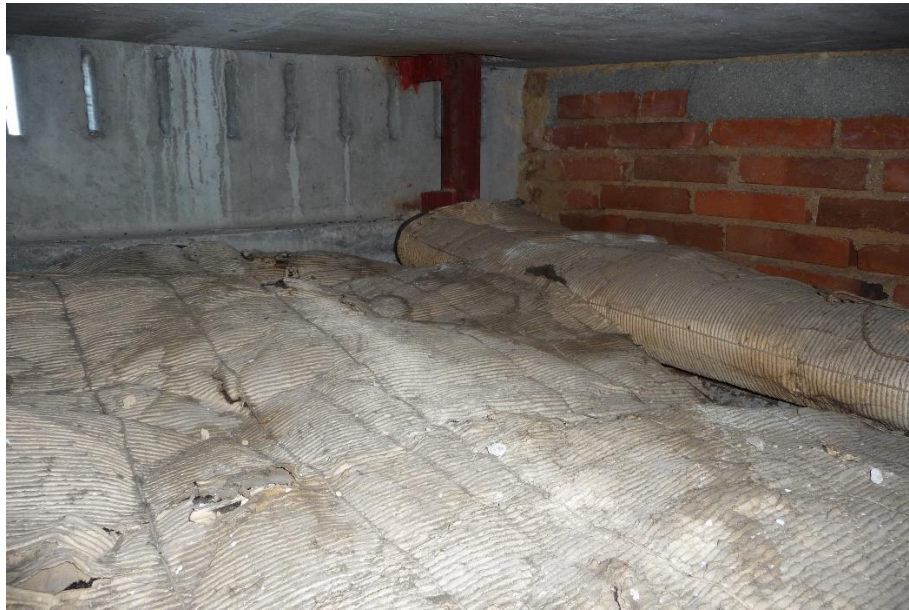
Obrázek 84: Provedení tepelné izolace dvouplášťové střechy katedrového objektu Zdroj: Dektrade
