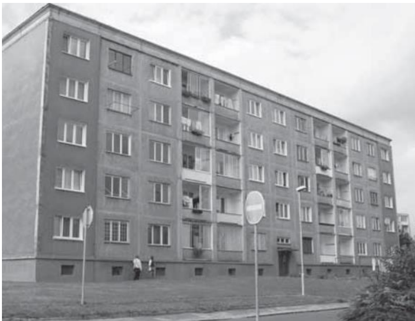
Obrázek 1: Průčelí domu panelové soustavy G 57 Zdroj: [2, str.15]
