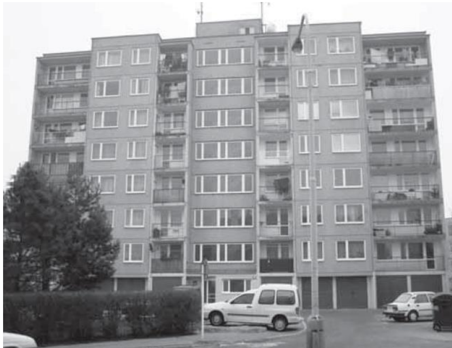
Obrázek 4: Průčelí domu soustavy VVÚ-ETA Zdroj: [2, str. 18]
