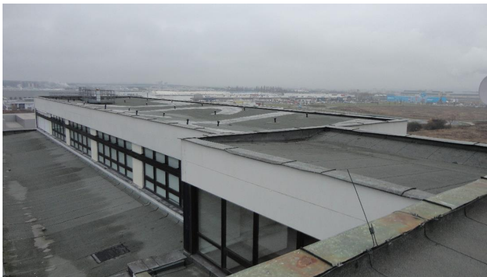
Obrázek 73: Pohled na střechu laboratorního objektu Zdroj: Autor
