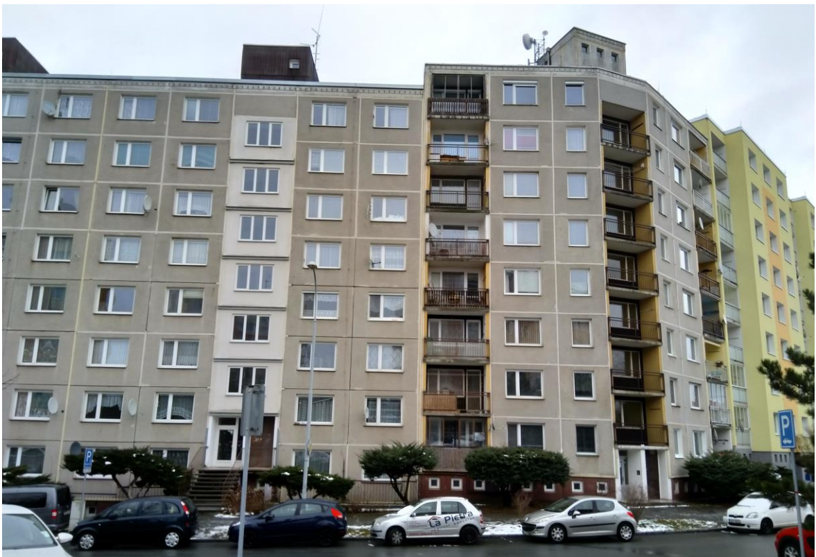
Obrázek 12 - Rohová sekce (vnější úhel s lodžiami), Plzeň Košutka (zdroj: Vlastní)
