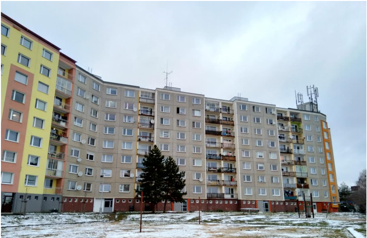
Obrázek 11 - Rohová sekce (vnitřní úhel), Plzeň Košutka (zdroj: Vlastní)
