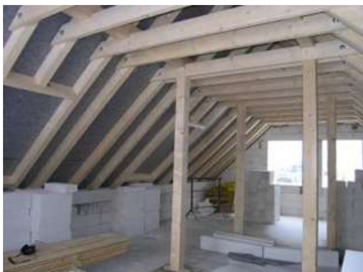
Obrázek 10 – Vaznicová soustava [30]
