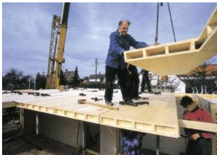
Obrázek 22 – Montáž krabicových stropů [33]
