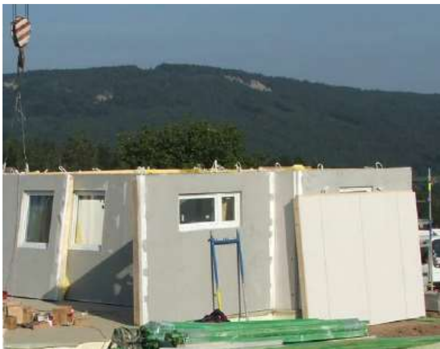
Obrázek 14 – Montáž panelového systému [37]
