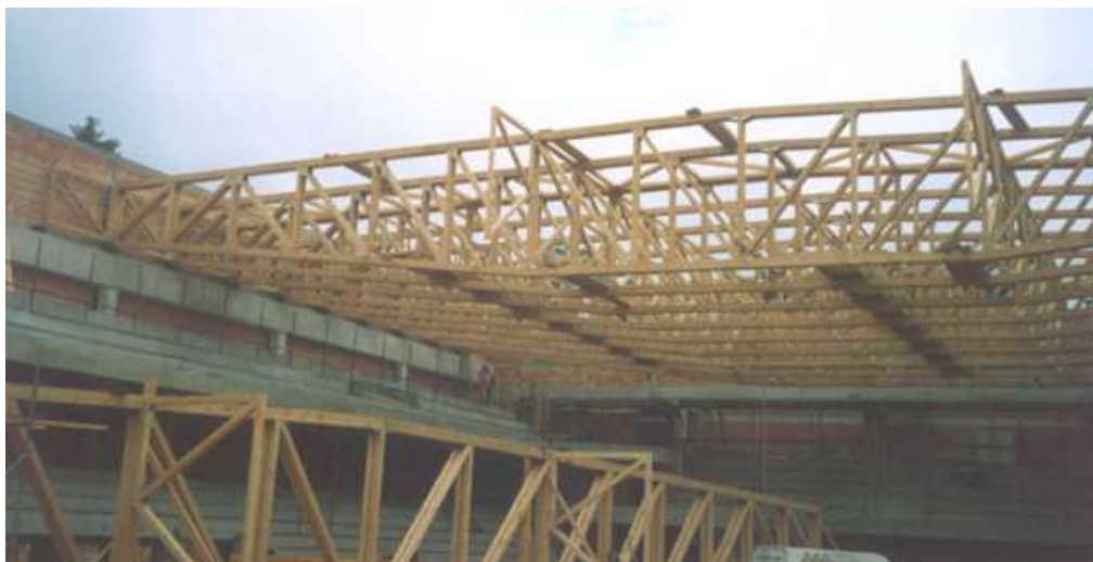
Obrázek 20 – Vazníková příhradová soustava uložena na ŽB průvlacích [42]
