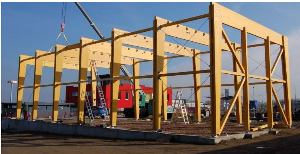
Obrázek 21 – Nosná konstrukce rámové plnostěnné haly [43]
