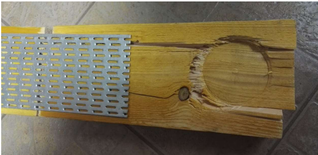
Obrázek 52 – Poškozený vzorek T2 [autor]
