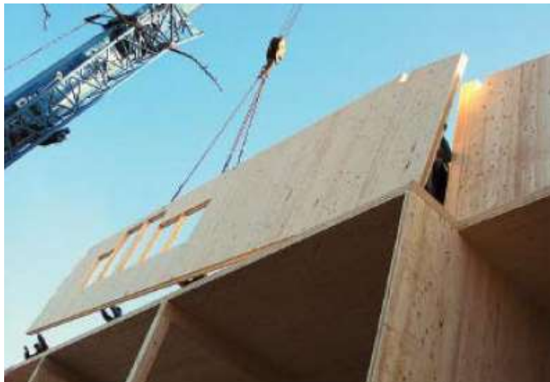
Obrázek 18 – Montáž dřevostavby z CLT panelů [37]
