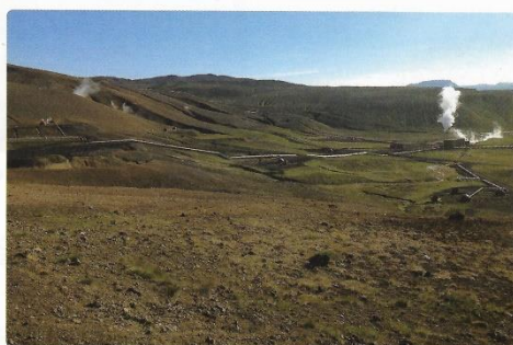
Geotermální elektrárna v oblasti činné sopky Krafla (Island)
