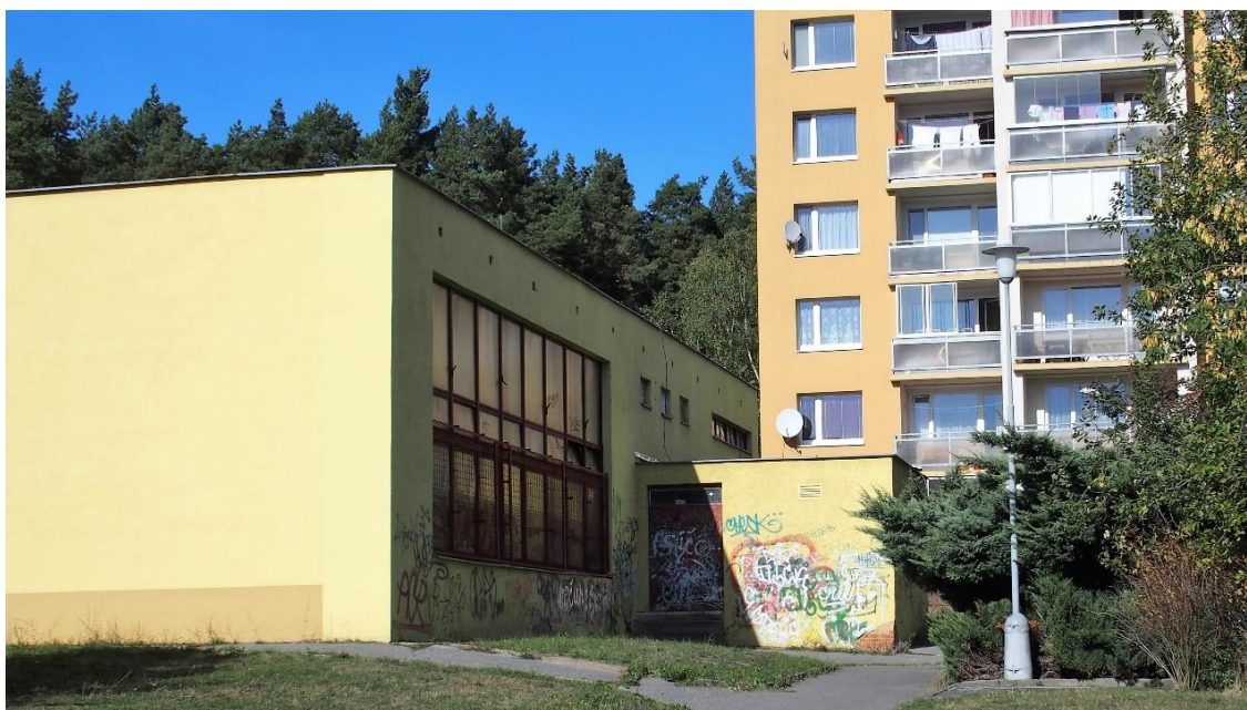
Obr. č. 6: Následky vandalismu
