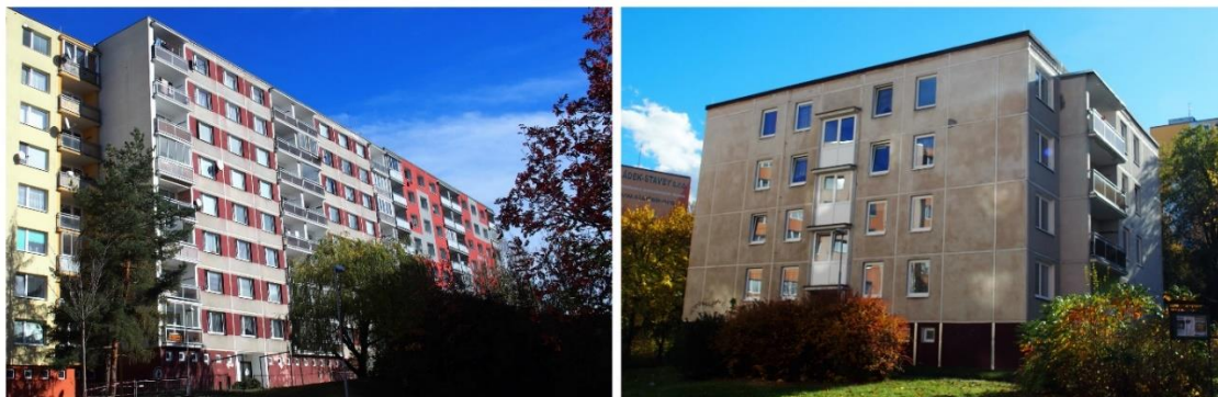
Obr. č. 14: Panelové domy s původní fasádou
