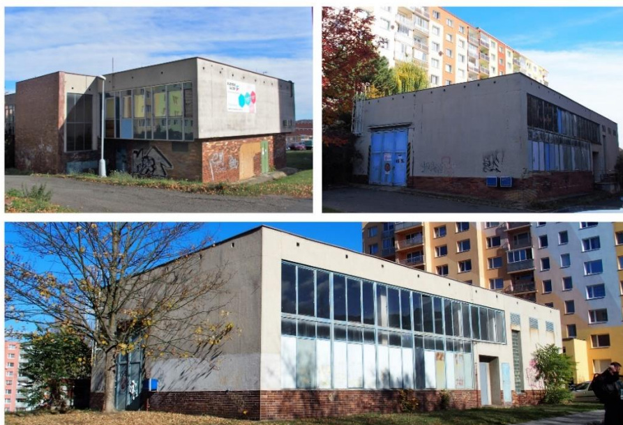
Obr. č. 15: Stavby technické infrastruktury v původním stavu
