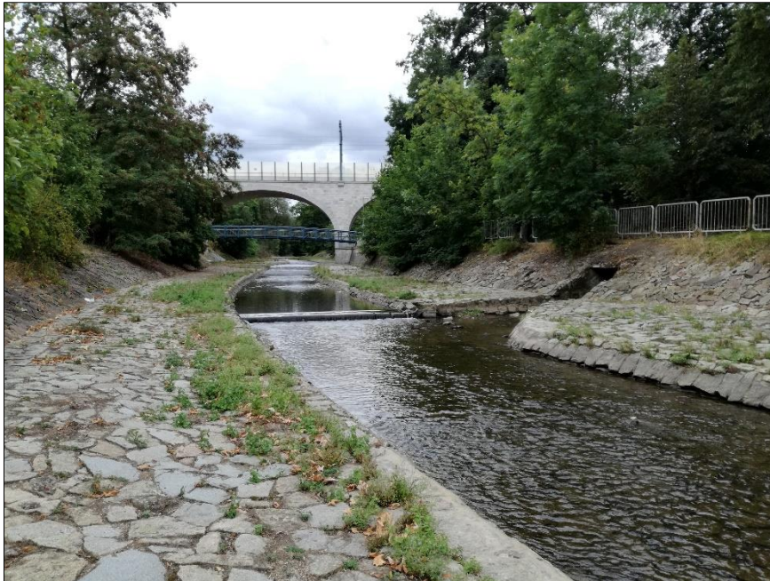
Obrázek č. 23: Koryto řeky Klabavy u železničního mostu (úsek č. 25) Zdroj: Vlastní fotodokumentace, 2018
