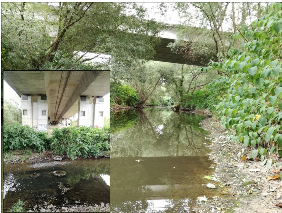
Obrázek č. 21: Nájezd na dálnici D5 (úsek č. 74) Zdroj: Vlastní fotodokumentace, 2018
