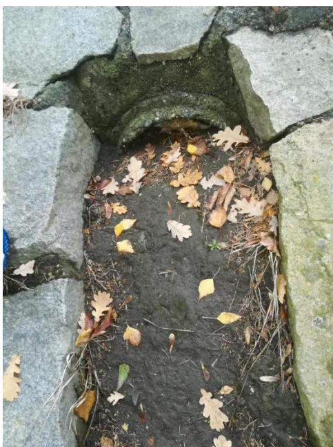
Obrázek č. 18: Zanesený dešťový oddělovač
