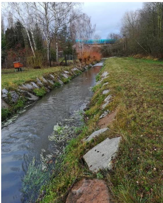
Obrázek č. 24: Regulace koryta před železničním mostem
