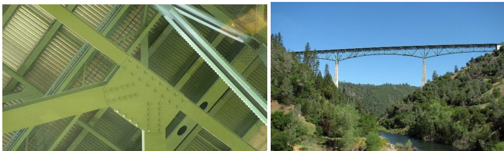
Obr. 37 – Kontrola spodní části mostu Foresthill [35]
