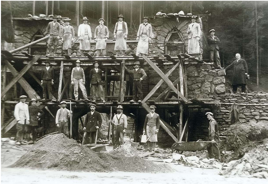
Obrázek 6: Stavba brány Lesního divadla
