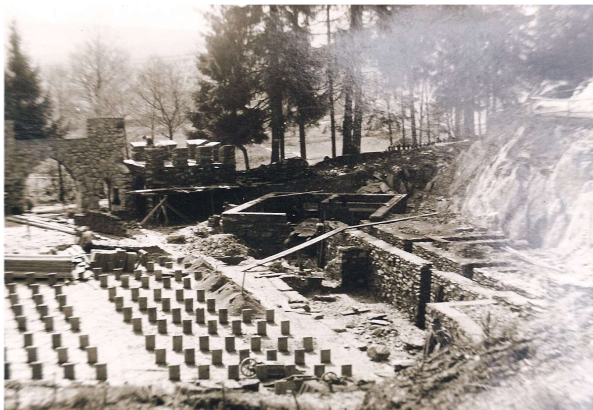
Obrázek 8: Stavba základů jeviště
