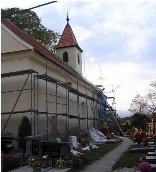
Obr. č. 7 Oprava kostela sv. Vavřince v Sulislavi
