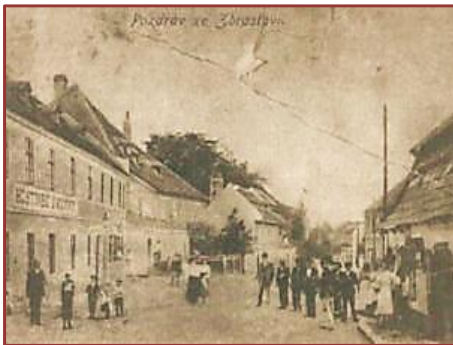
Příloha č. 3 U národní galerie č. p. 471 Amtshaus (hotel Darwin) 200
