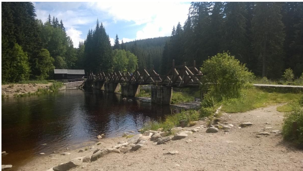
Obr. 15.: Hradlový most, Rechle (Foto: Natálie Odrášková, 7.7.2018)
