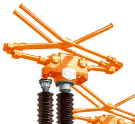
Obr. 1.2. Pantografický odpojovač [3]
