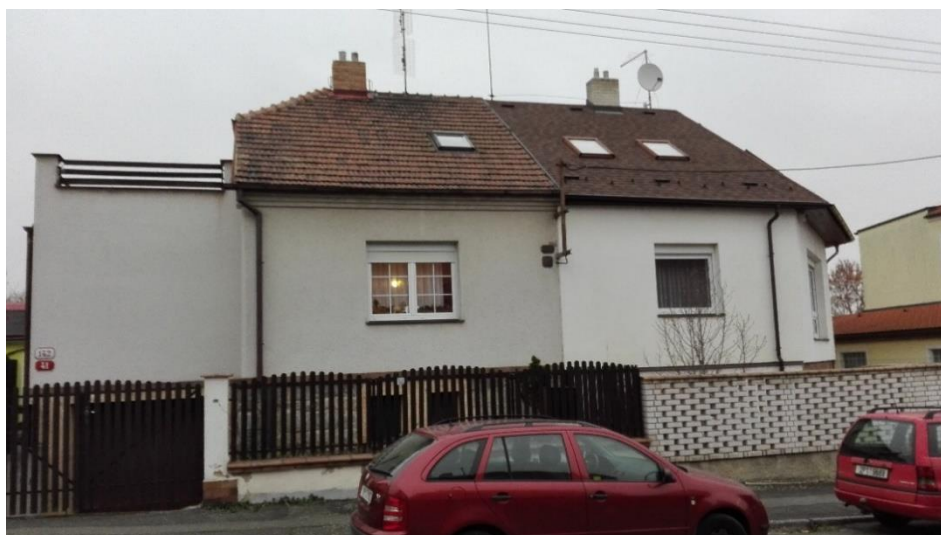
Obr. 4.2 Pohled z ulice (objekt vlevo), plocha střechy orientována na jihovýchod
