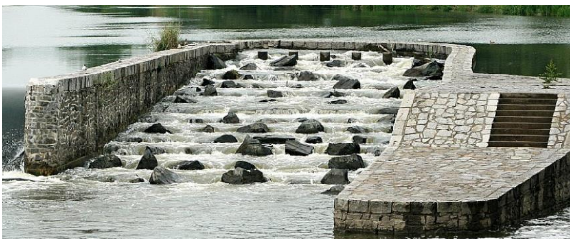
Obr. 3.10.: Rybí přechod na Břeclavsku (možné řešení v lokalitě Dolanského mlýna)
