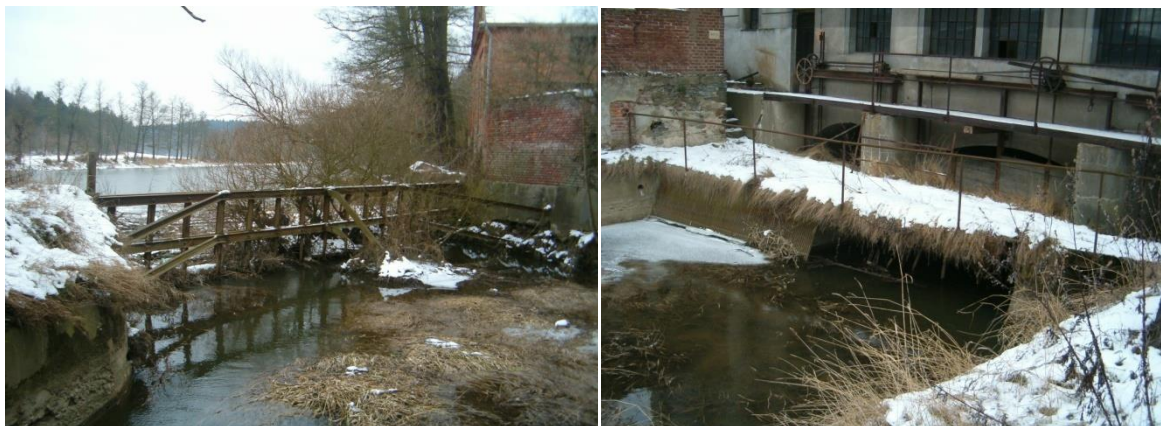
Obr. 2.3.: Stav objektu Dolanského mlýna náhon vody na turbínu (síta náhonu)
