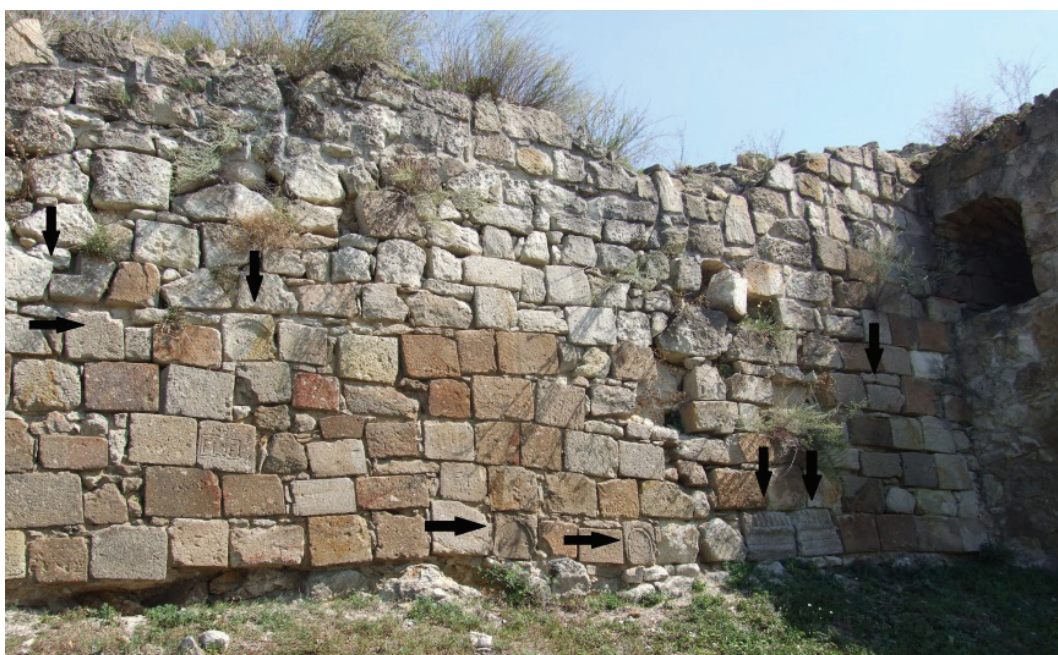
obr. 3 Obvodová hradba předhradí vystavěná za použití lomového kamene, staršího rozebraného kvádríkového zdiva i starších tesaných architektonických článků (označeny šipkami). Foto a úprava autor.
