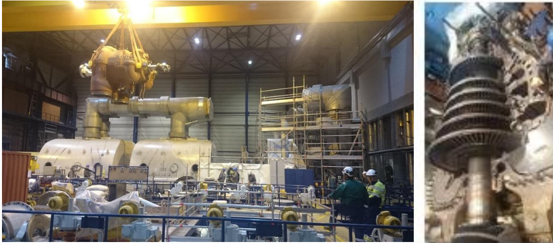
Obrázek 2: Montáž nového VT dílu (vlevo) a původní šestikolový VT rotor (vpravo).
