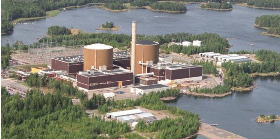
Obrázek 1: Vnější pohled na jadernou elektrárnu.
