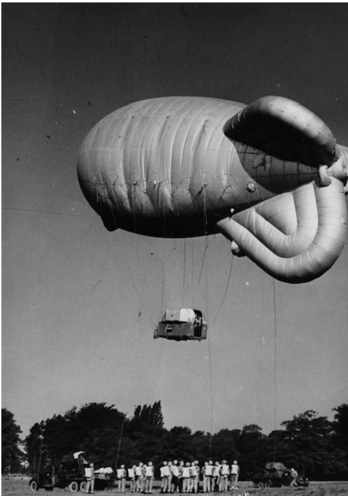
Obrázek č. 27. Balón byl nejméně oblíbeným prostředkem k vysazení parašutistů, neboť v tichém a nehybném koši se výška zdála zrádnější...Otevírání padáku výtažným lanem také z důvodu nulové rychlosti v okamžiku vysazení trvalo déle. Byl však levnější na provoz a ve stejném čase z balonu dokázalo vyskočit více mužů, než z letounů.
