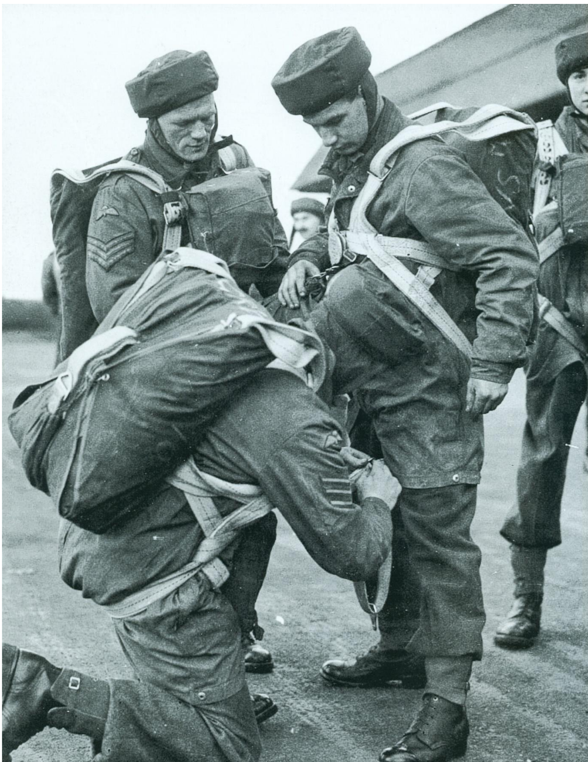
Obrázek č. 35. Parašutisté se navzájem strojí před cvičným seskokem. Výtažné lano, umístěné ve vertikálních kapsách na chlopních obalu padáku, opět identifikuje starší verzi Mk.I. Na konci výtažného lana je jasně patrné ocelové oko, které se po nástupu do letadla připevňovalo k prodlužovacímu popruhu. Tím byla zajištěna funkce tzv. nuceného otevření. Rukávový znak v podobě okřídleného padáku dokazuje, že zobrazení parašutisté již prodělali základní výcvik v seskoku padákem a pokračují ve výcviku speciálním nebo udržovacím.
