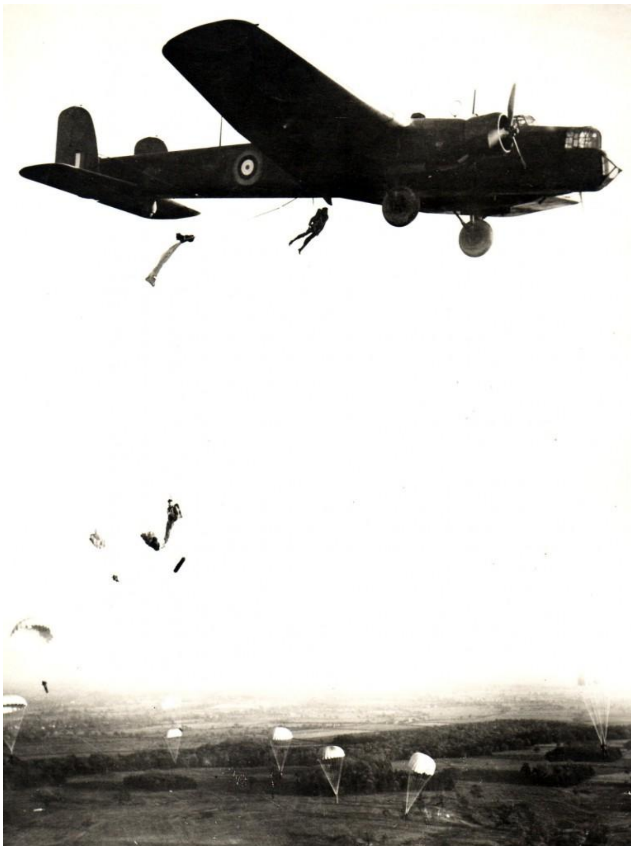
Obrázek č. 14. Momentka z výcviku v Ringway. Těsně pod letounem Whitley prochází krátkou fází volného pádu parašutista, který opomněl po opuštění letounu držet nohy u sebe. Dále pod letounem vlevo pokračuje v pádu jeho kolega, který vyskočil před ním. Napjaté nosné šňůry mu již vytahují vrhlík z upoutaného kontejneru padáku (kontejner, připoutaný výtažným lanem k letounu, visí pod zadním křídlem).
