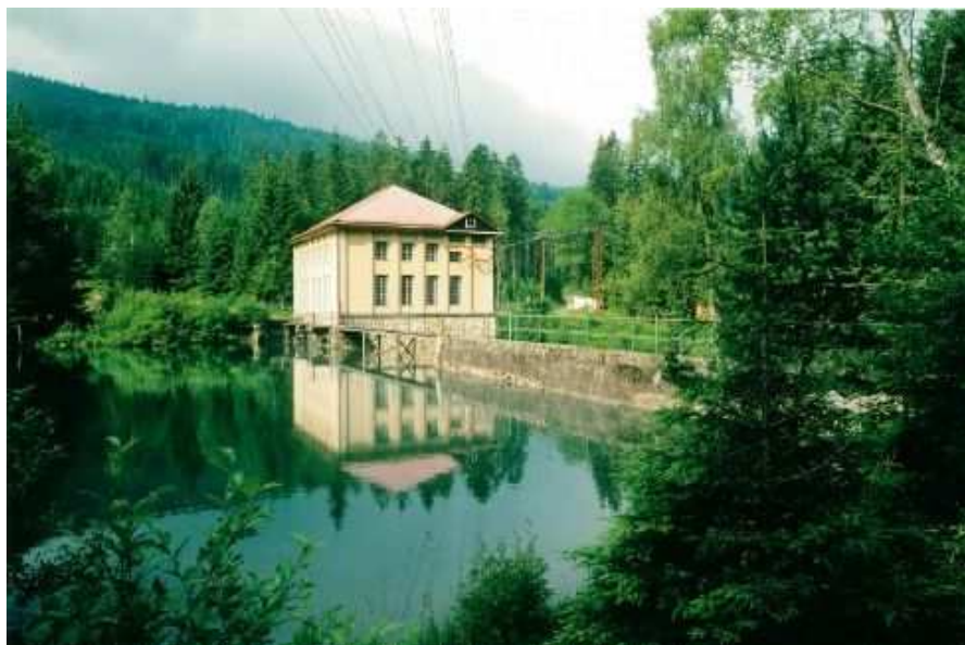
Obr. 5.2[17]: Přečerpávací vodní elektrárna Černé Jezero
