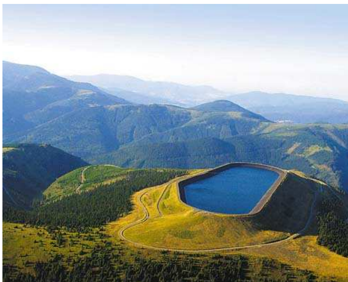
Obr. 5.3[28]: Přecherčpávací vodní elektrárna Dlouhé Stráně (horní nádrž)
