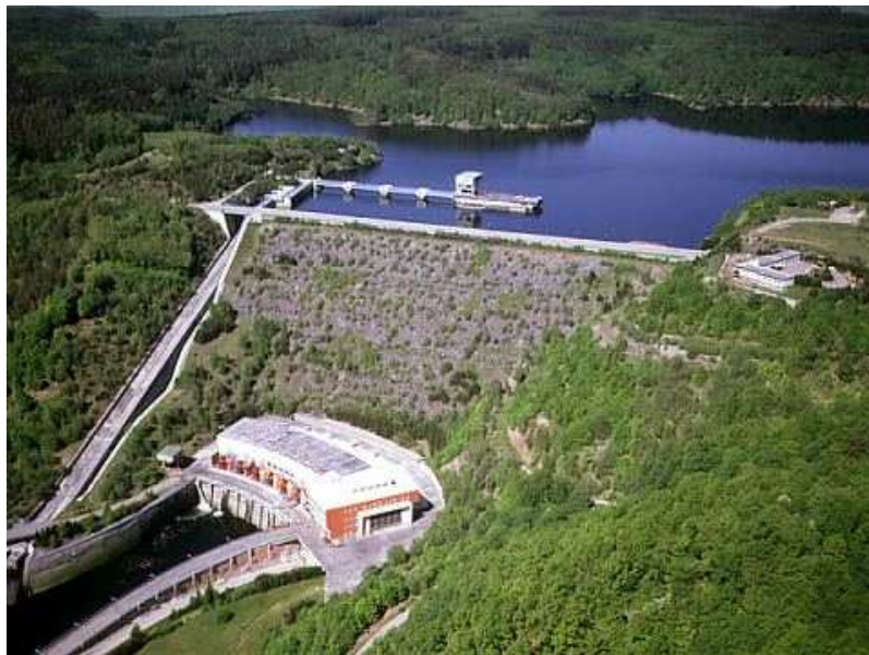
Obr. 5.5[30]: Přečerpávací vodní elektrárna Dalešice
