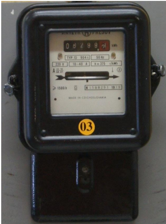
Obrázek 3 Jednofázový indukční elektroměr
