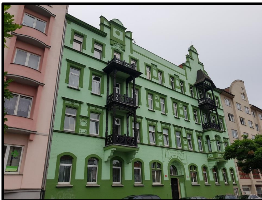
Příloha č. 12 – Dům v Hálkově ulici č. p. 1177/18. 178
