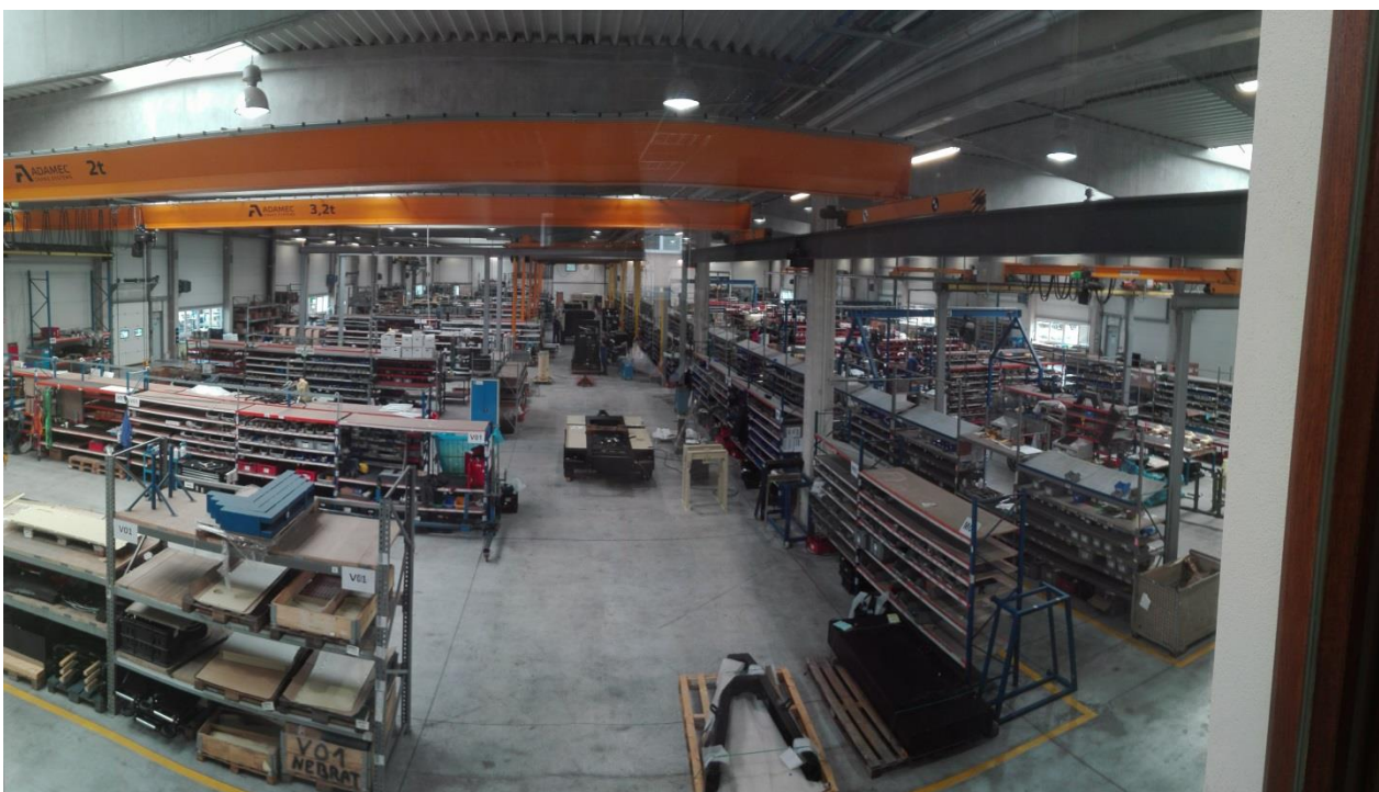
Obrázek 5-2: Současný stav výrobně - montážní haly
