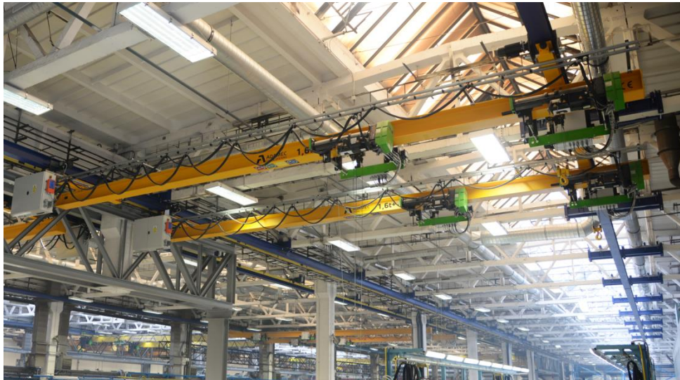
Obrázek 2-18: Podvěsný jeřáb [21]
