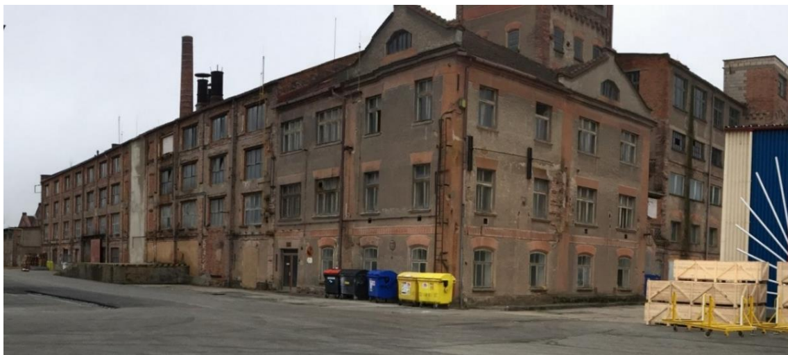
Obr. 5-2: Skladovací hala materiálu
