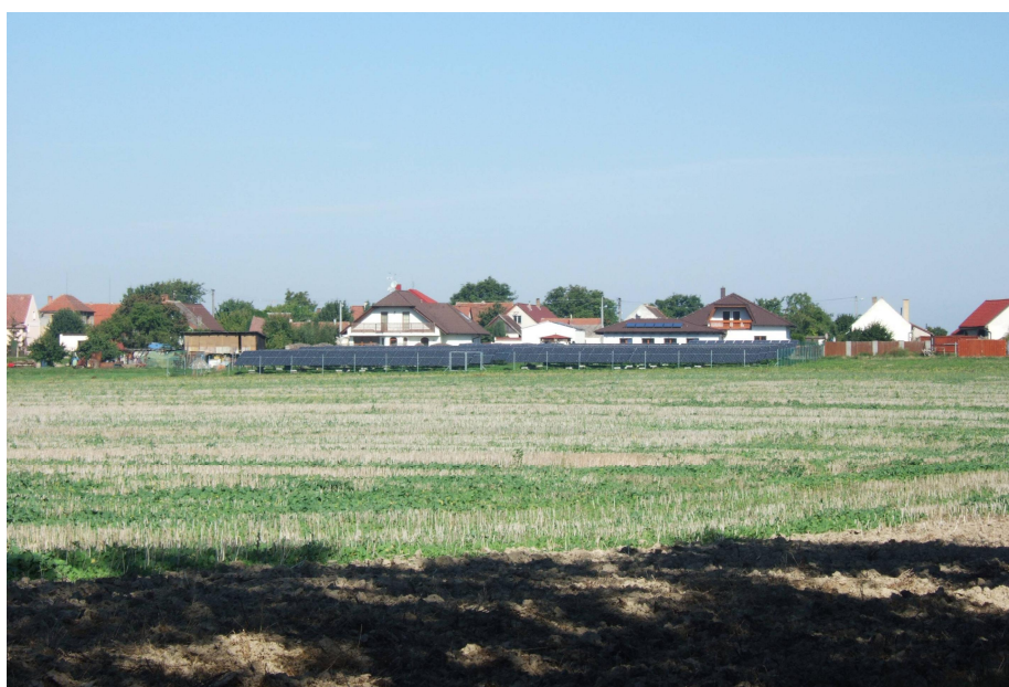
Obr. 3: Osazené panely FV výrobní 70 kW v obci Horušany
