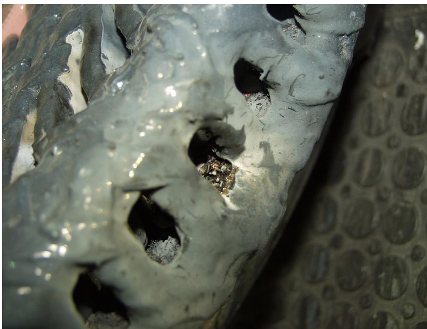
Obr. 1.1 Vypálená izolace na statoru po mezizávitovém zkratu
