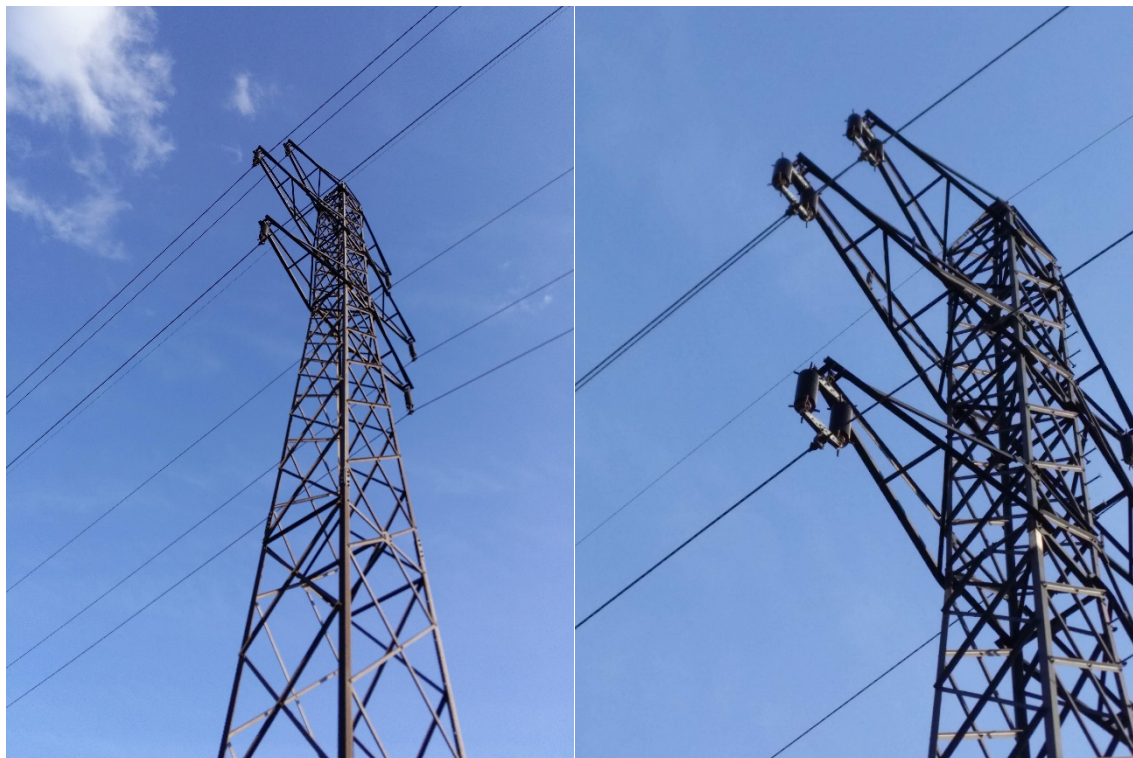
Obr. 5: Stožár venkovního vedení, zdroj: autor
