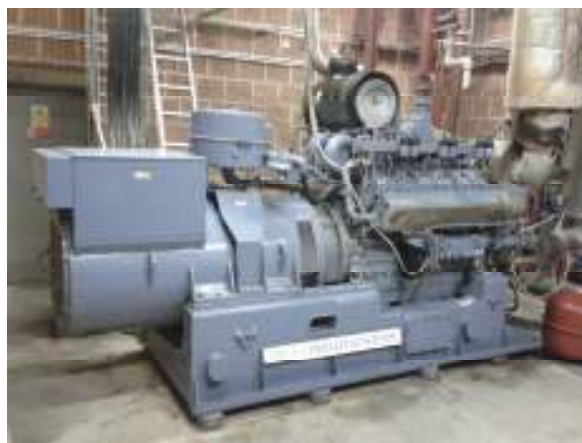
Obr. 5.6 Kogenerační jednotka Deutz
