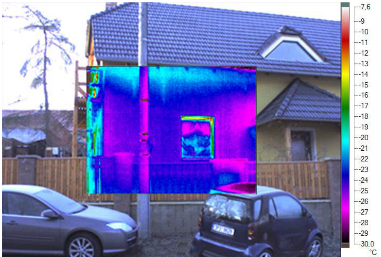
Obr.6 Detail okna - proložení digitálního snímku termogramem
