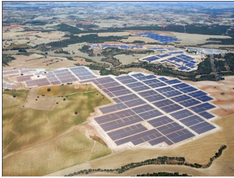
Obr. 24 Fotovoltaický park u Olmedilla de Alarcón
