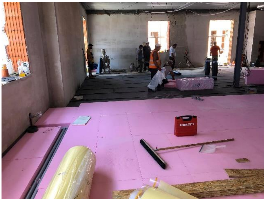
Obrázek 14 – Pokládka Mirelonu s fólií 2
