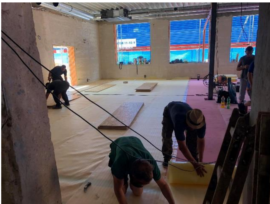
Obrázek 13 – Pokládka Mirelonu s fólií
