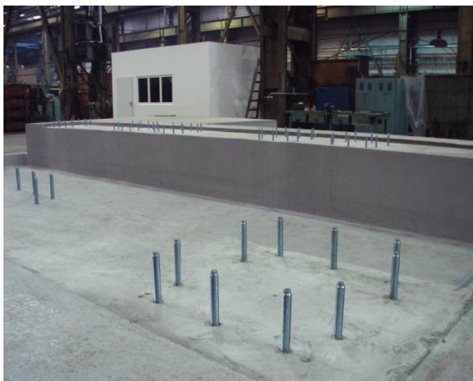
Obr. 14: Betonový základ s navrtanými šrouby
