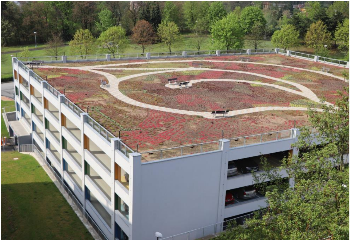
Obrázek 13: Ozeleněná střecha parkovacího domu v areálu FN Plzeň
