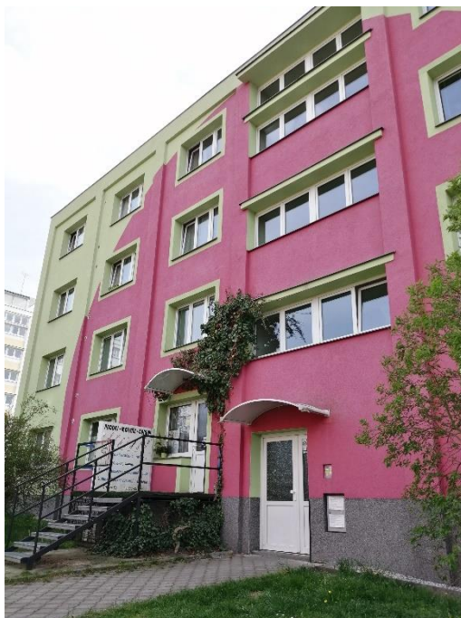
Obrázek 6: Popínavá rostlina na panelovém domě v ulici Staniční Zdroj: Vlastní fotografie (17.4.2020)
