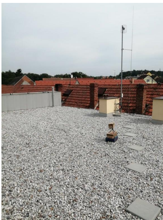
Obrázek 21: Přístroj Kestrel 4000 umístěný na střeše s kačirkem na budově Obecního úřadu Letkov
