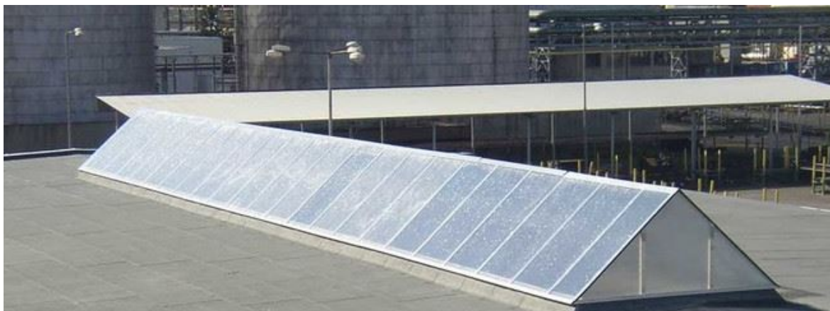
Obrázek 31: Sedlový světlík na střeše haly [39]
