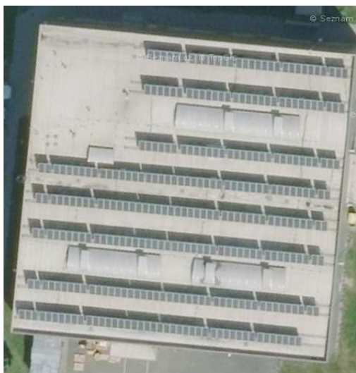
Obrázek 28: Průmyslová hala, střešní světlíky a fotovoltaika
