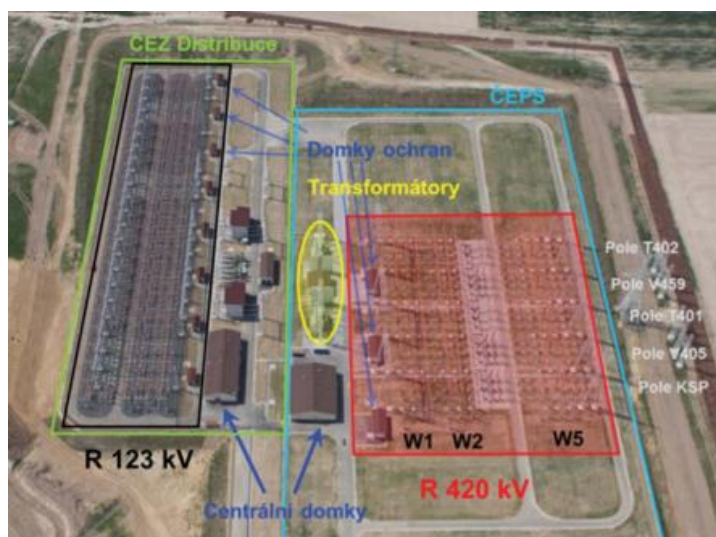
Obr. 1 - Elektrická stanice v Kletné [1]
