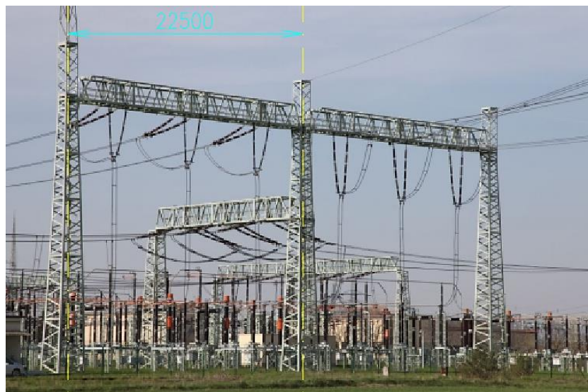
Obr. 20 - Hlavní ocelová konstrukce [15]
