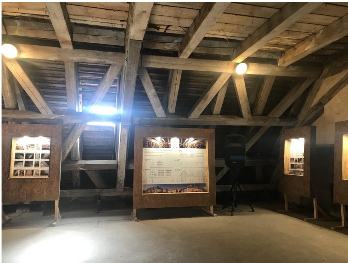
Obr. č. 8 Snímek z prohlídky krovů
