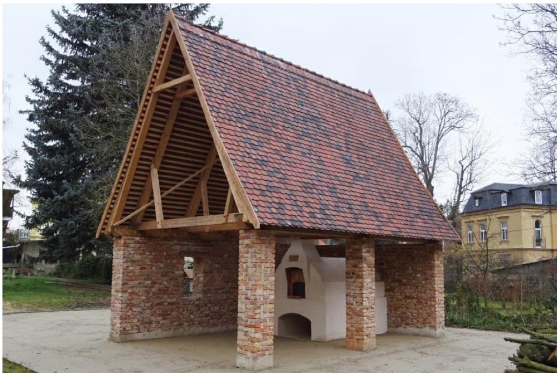
Obr. č. 11 Stávající podoba přístřešku chlebové pece
