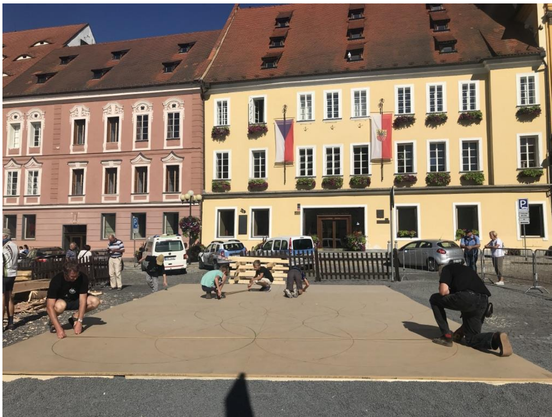
Obr. č. 10 Geometrické vytyčování konstrukce
