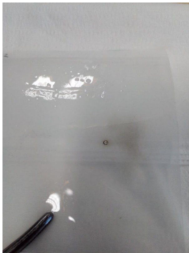
Příloha C: Díra po elektrickém průrazu.
