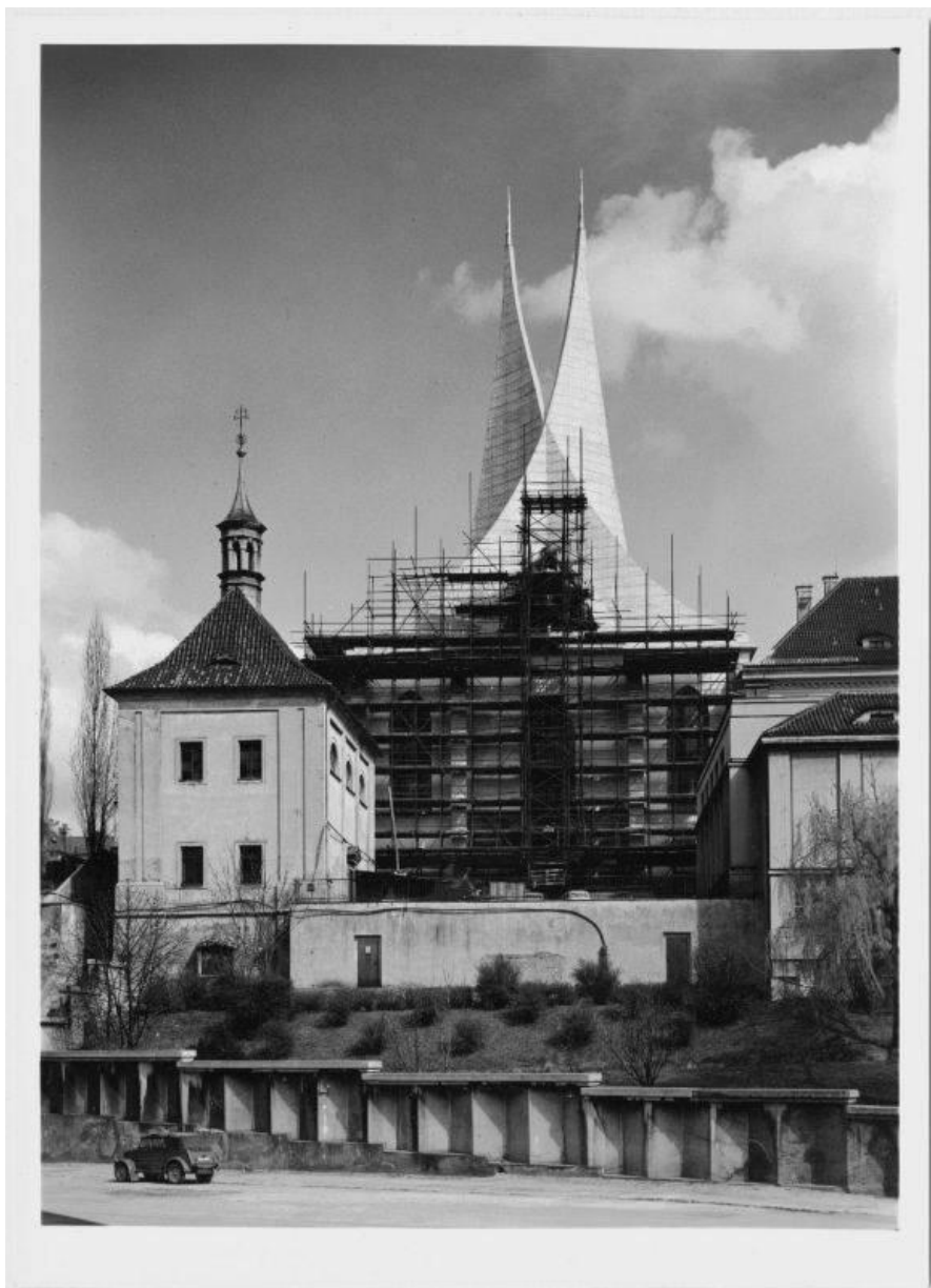
7 Západní průčelí kostela při rekonstrukci zastřešení, autor reprodukce: Tereza Šťastná, 1968.
