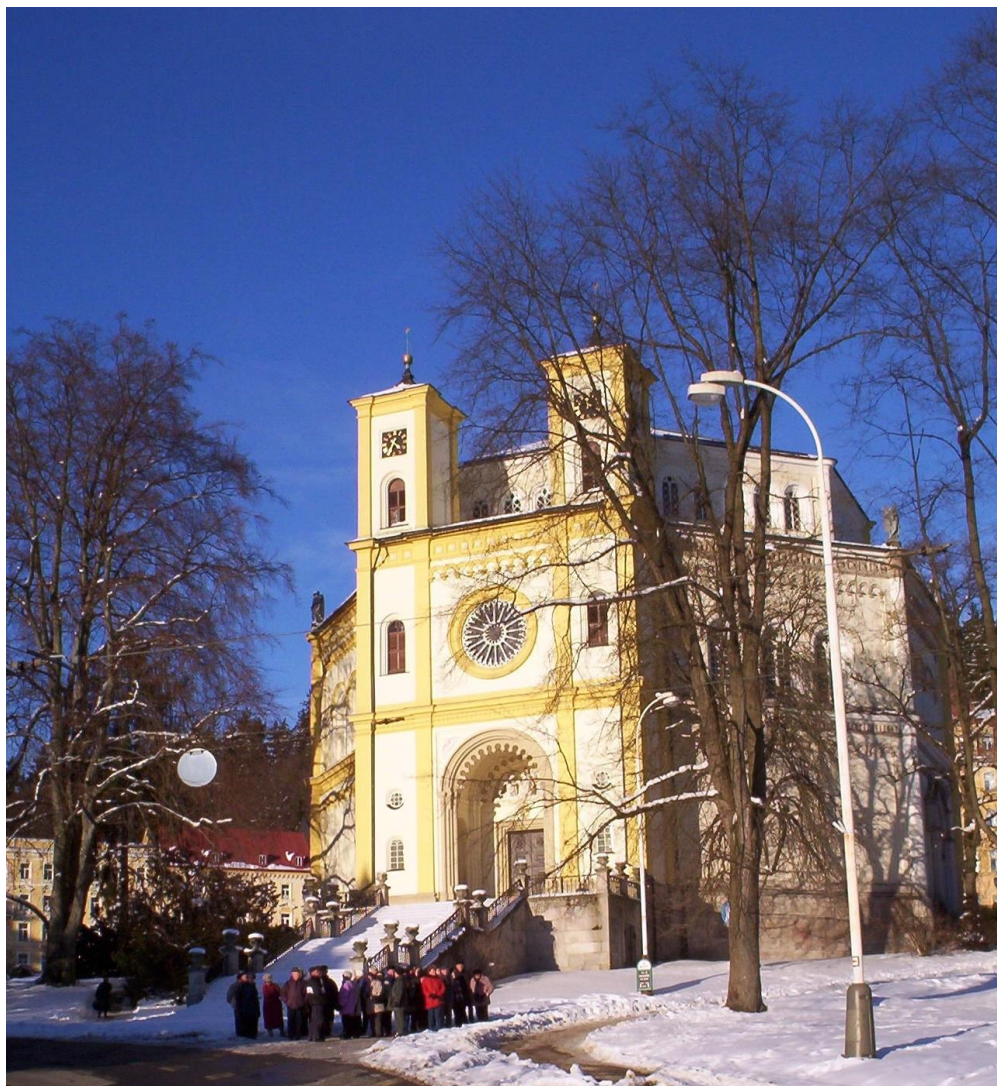
Obrázek 14 Na fotografii z roku 2003 je jasně patrné, že opravy minimálně dvou stran kostela nejsou ještě dokončeny.
