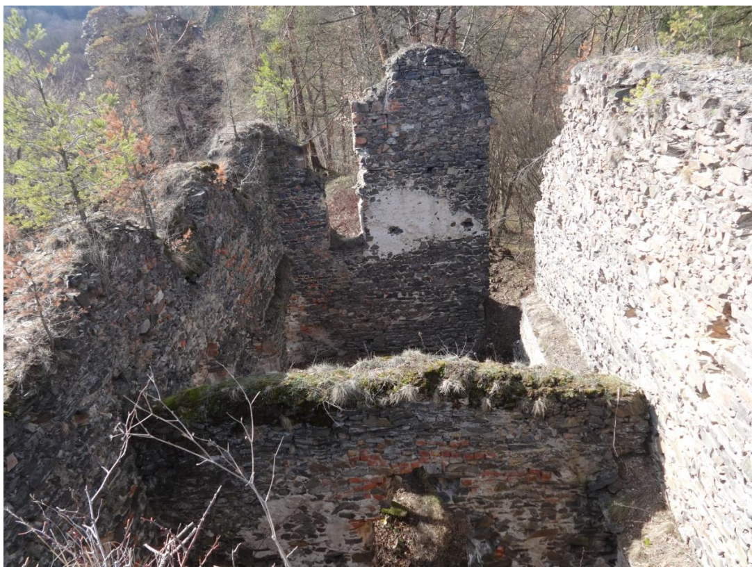
Obr. 72. Zbořený Kostelec. Pohled do interiéru severní budovy jádra hradu (foto autorka, 2019).
