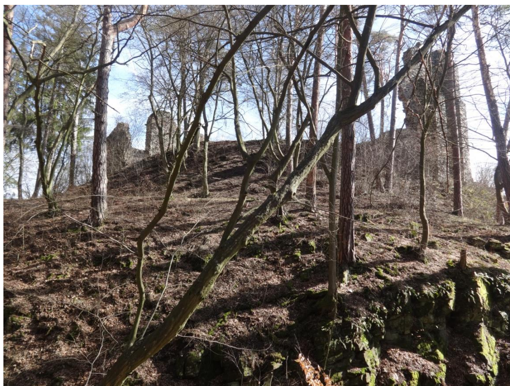
Obr. 67. Zbořený Kostelec od severozápadu (foto autorka, 2019).
