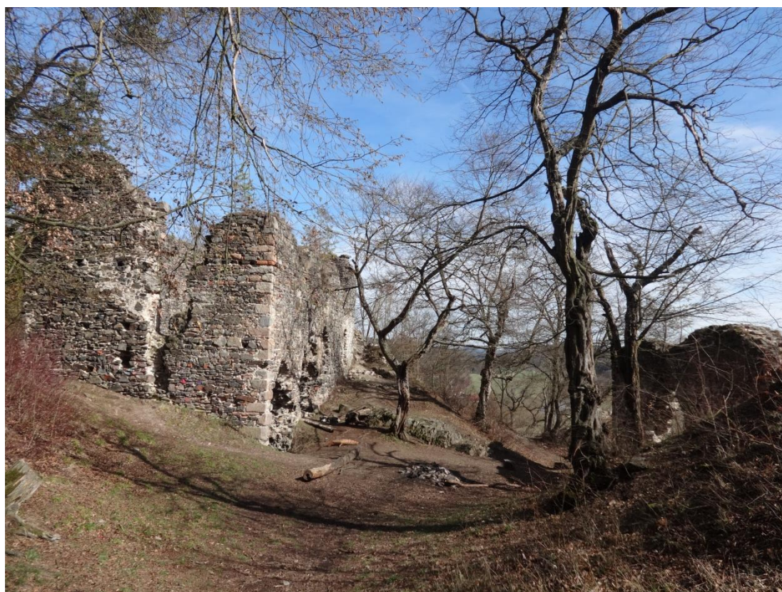
Obr. 71. Zbořený Kostelec. Severní (vlevo) a jižní (vpravo) budova hradního jádra v pohledu od západu (foto autorka, 2019).
