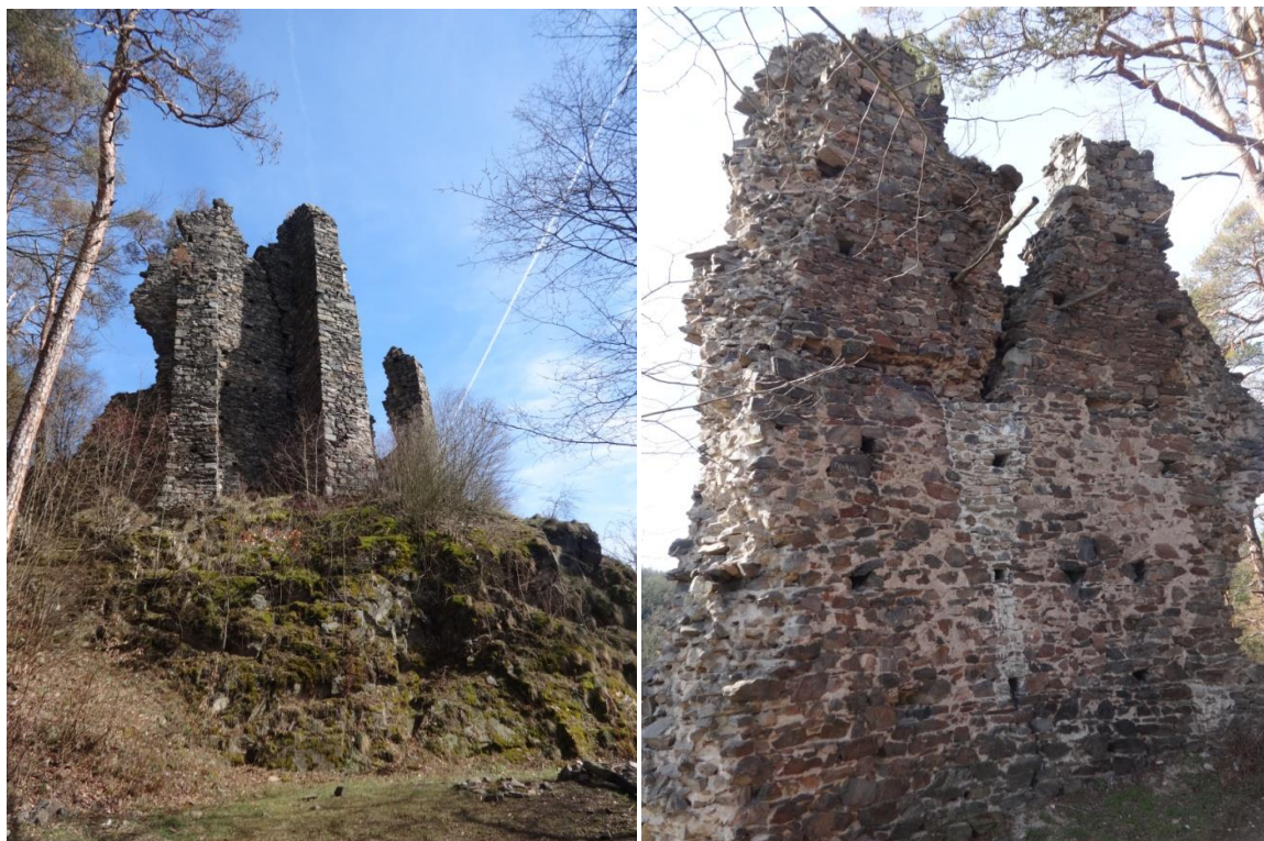
Obr. 70. Zbořený Kostelec. Vnější (vlevo) a vnitřní (vpravo) strana obvodové zdi západního paláce s opěrnými pilíři (foto autorka, 2019).
