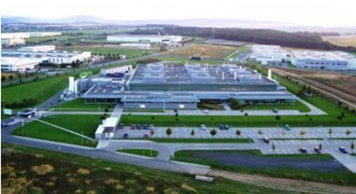
obr. 1-2: Sídlo firmy Valeo v Žebráku[2]
