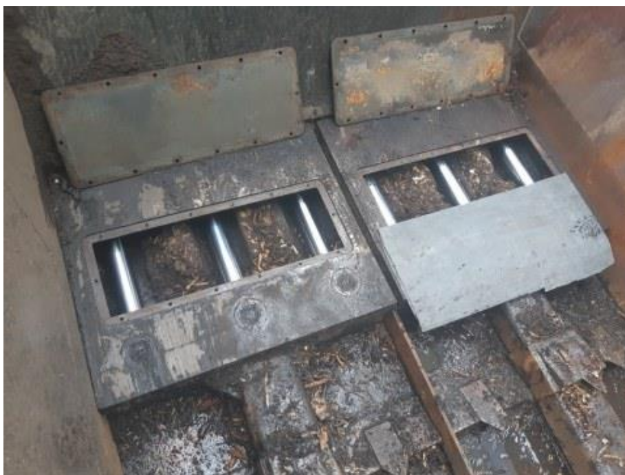
Obrázek Příloha č.1-8 Vnitřní prostor zavážecích lopat[autor].
