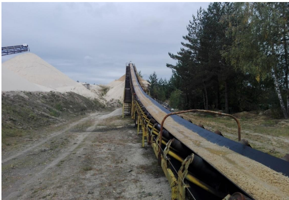
Obr. 2-1 Pozemní pásová doprava (vlastní zpracování)
