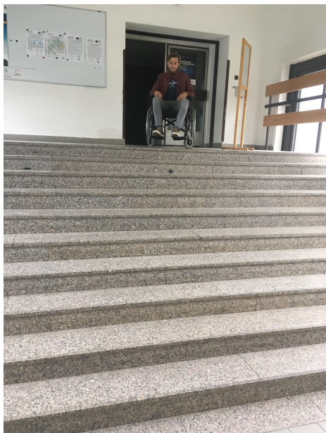
Obrázek 22 Schody ke katedře energetiky na FST (vlastní)
