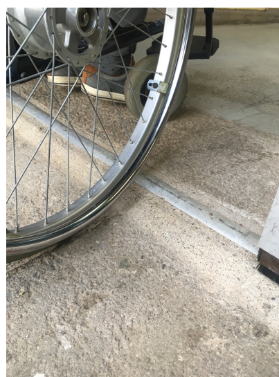
Obrázek 18 Severní vchod do fakulty FST (vlastní) Obrázek 19 Práh v severních dveřích fakulty FST (vlastní)
