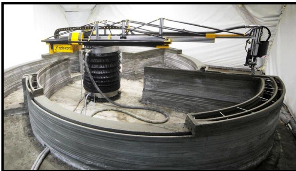
Obr. 27: Tisk stěn pomocí tiskárny s robotickou rukou, společnost Apis-Cor, Rusko
