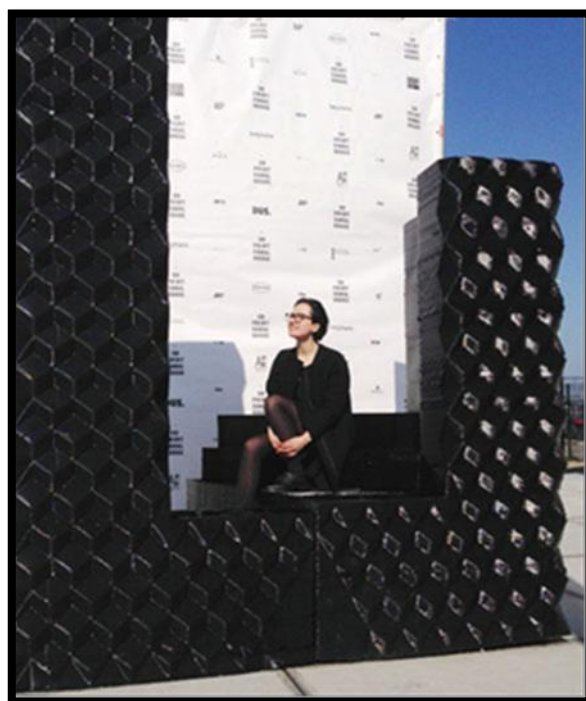
Obr. 46: Ukázka stavebního bloku pro Canal House
