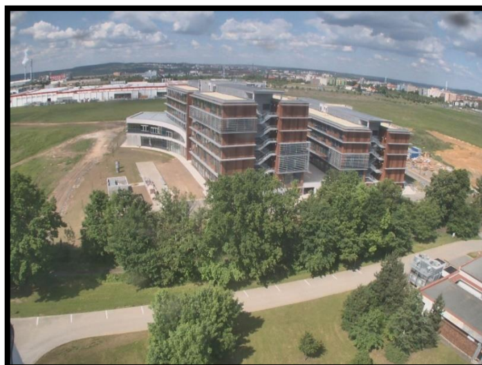
Obr. 51: Pohled na fasádu budovy NTIS a CTPVV
