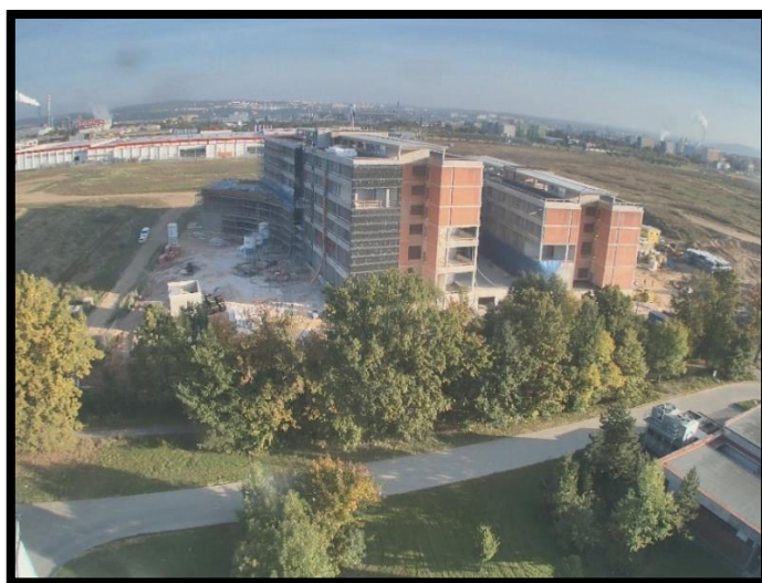
Obr. 50: Zděný obvodový plášť budovy NTIS a CTPVV
