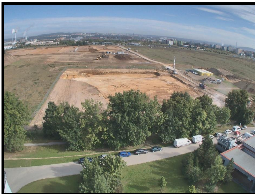
Obr. 49: Výkopové práce na stavbě budovy NTIS a CTPVV
