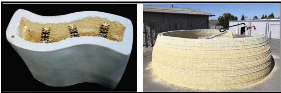
Obr. 25: Ukázka vytištěného bednění z PUR pěny a tisk malého objektu metodou 3D pěnový tisk
