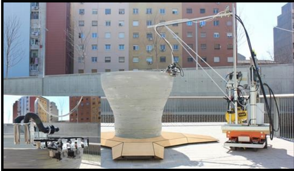
Obr. 28: Ukázka tisku pomocí mobilní 3D tiskárny, IAAC Barcelona, Španělsko
