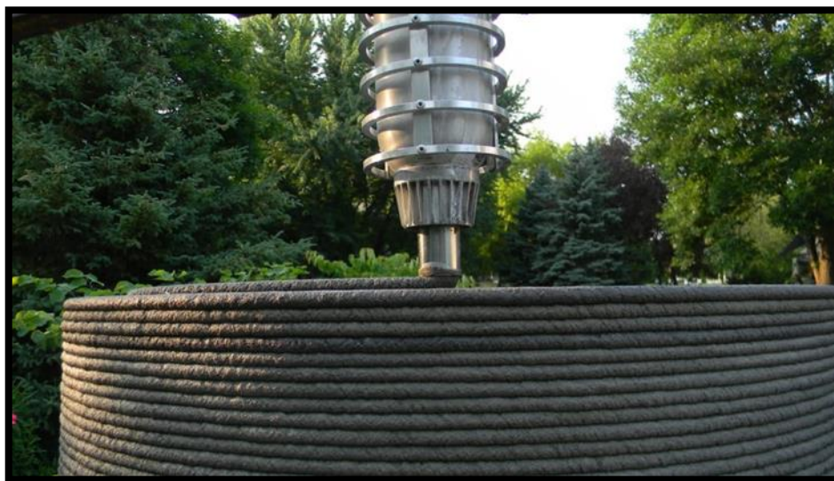
Obr. 17: Ukázka vytlačování cementové malty z tiskové hlavy, USA
