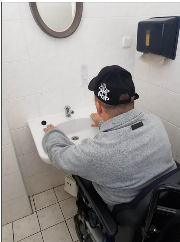
Obrázek 125 - Bezbariérové umyvadlo ve společné předsíni (umyvadlo není v bezbariérové WC kabině, zrcadlo příliš vysoko umístěné), zdroj: autorka DP
