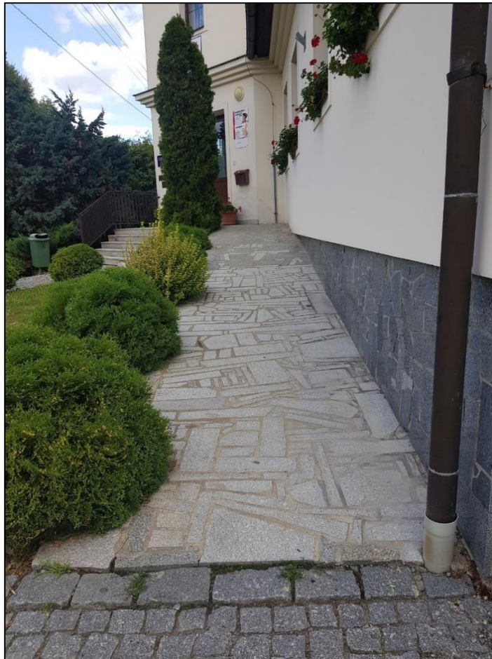
Obrázek 54 - Chodník ve sklonu podél Budovy OÚ 2 (chodník vede na podestu, kde je nutné pro vstup do budovy zdolat 120 mm vysoký stupeň, přiléhající keře zasahují do průchozí šířky, vhodné by bylo zábradlí na vnější straně), zdroj: autorka DP
