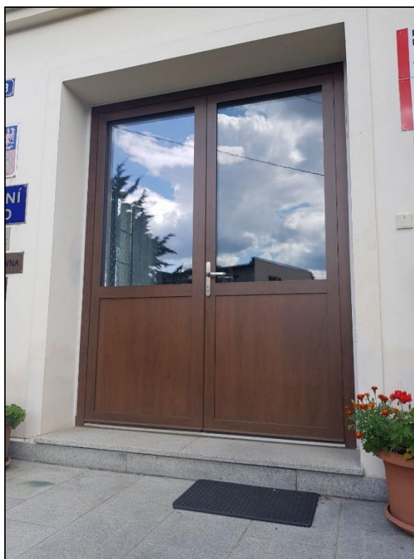
Obrázek 57 - Hlavní vchod do Budovy OÚ 2 (pohled na vstupní dveře a již zmiňovanou překážku o výšce 120 mm), zdroj: autorka DP
