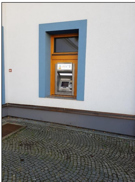
Obrázek 41 - Bankomat u Budovy OÚ 1 (správné výškové řešení, umožněné použití osobě na vozíku), zdroj: autorka DP
