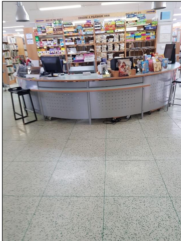
Obrázek 117 - Výpůjční pult v městské knihovně (správné výškové řešení, pult umožňuje částečný podjezd vozíkem – pro ústní komunikaci vyhovující), zdroj: autorka DP
