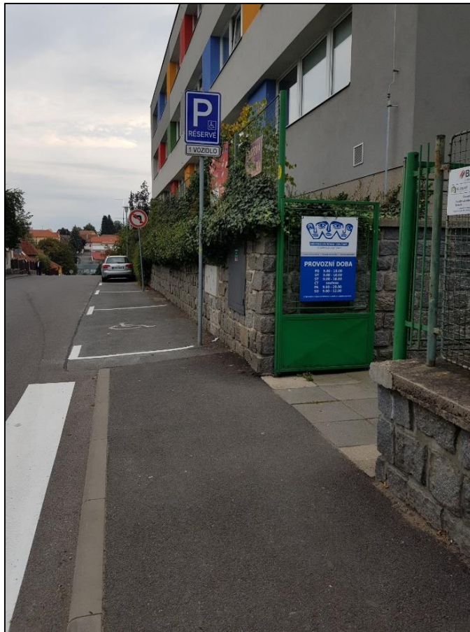
Obrázek 111 - Vyhrazené parkovací podélné stání (nevhodné řešení, malá šířka parkovacího místa – osoba na vozíku musí vystoupit do vozovky), zdroj: autorka DP
