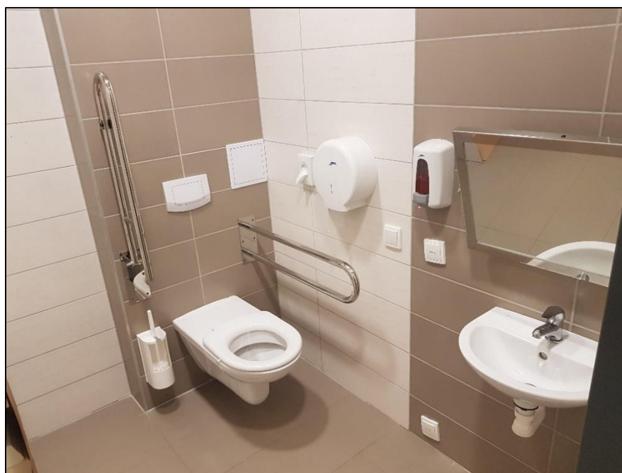
Obrázek 28 - Příklad správně provedené bezbariérové WC kabiny, zdroj: autorka DP
