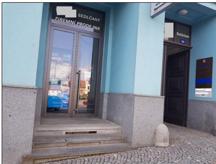
Obrázek 65 - Vstup do obchodu a do průchodu (do obchodu lze použít pouze vstup se schodišťovými stupni, cedule u průchodu je nekontrastní, průchod vede k venkovnímu výtahu), zdroj: autorka DP
