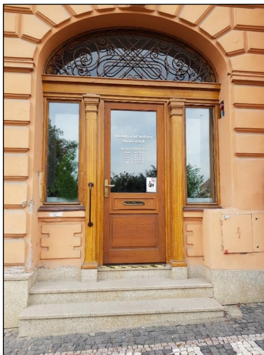
Obrázek 97 - Hlavní vchod do Budovy MěÚ 3 (pouze po schodišťových stupních, chybí zvonek), zdroj: autorka DP
