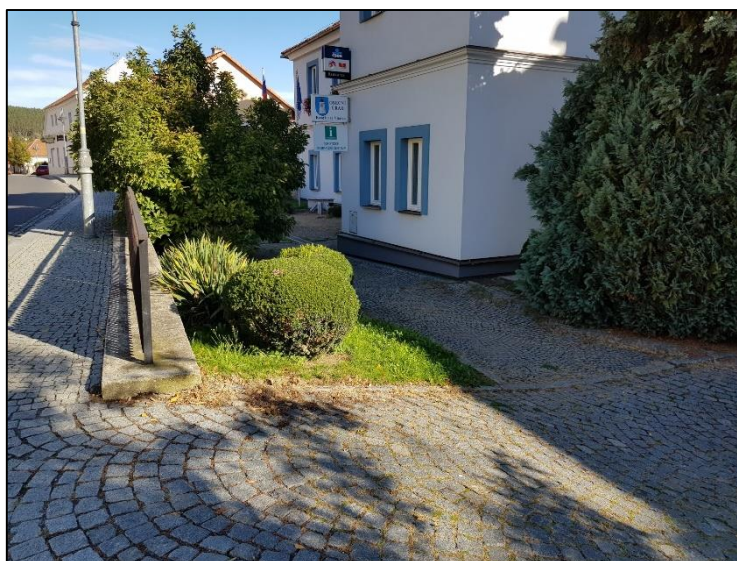
Obrázek 40 - Chodník ve sklonu (umožněný přístup osobě na vozíku), zdroj: autorka DP
