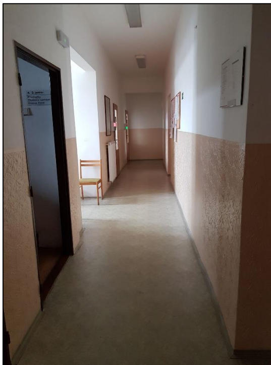
Obrázek 87 - Chodba v 2.NP: Budova MěÚ 2 (rozměrově vyhovující), zdroj: autorka DP
