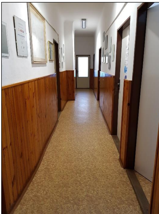
Obrázek 44 - Chodba v 2.NP v Budově OÚ 1 (šířka chodby je vyhovující i v místě krátkodobého zúžení, dveře jsou s prahy s výškou větší jak 20 mm), zdroj: autorka DP
