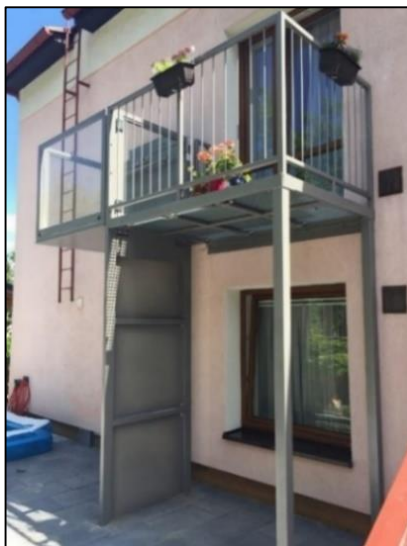
Obrázek 50 - Příkladná ukázka svislé plošiny s neuzavřenou jízdní dráhou a balkónem (vyhláška povoluje u tohoto typu plošiny zdvih maximálně 2 metry, na trhu lze sehnat tento typ plošiny s vyšším zdvihem) [27]
