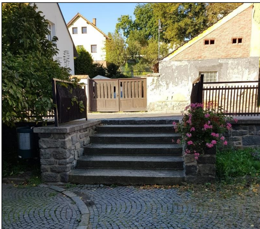
Obrázek 39 - Schodiště před Budovou OÚ 1 , pohled od vchodu (chybí kontrastní značení prvního a posledního stupně, chybí madla po obou stranách), zdroj: autorka DP
