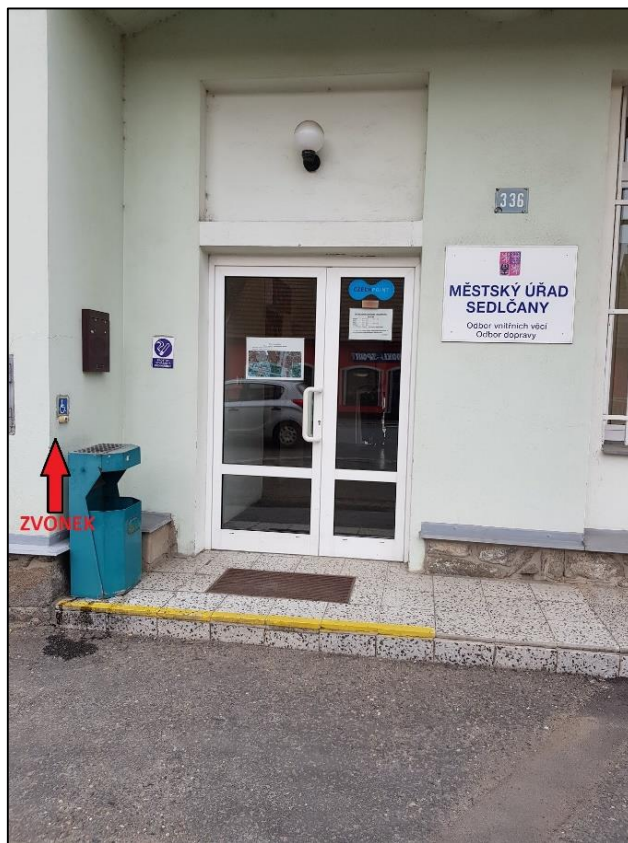
Obrázek 85 - Hlavní vchod do Budovy MěÚ 2 (zvonek je v dosahové vzdálenosti osobě sedící na vozíku, neumožněný vstup do budovy – překážkou je schodišťový stupeň), zdroj: autorka DP
