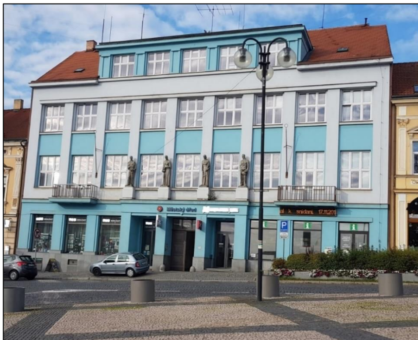
Obrázek 63 - Pohled na první budovu Městského úřadu Sedlčany, zdroj: autorka DP
