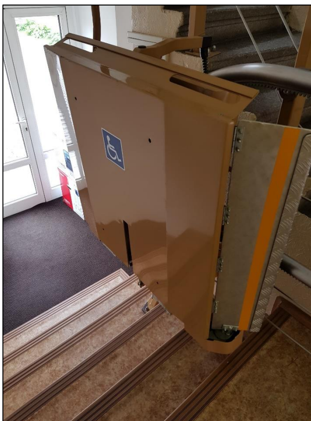
Obrázek 89 - Schodišťová plošina ve složené poloze v Budově MěÚ 2 , zdroj: autorka DP
