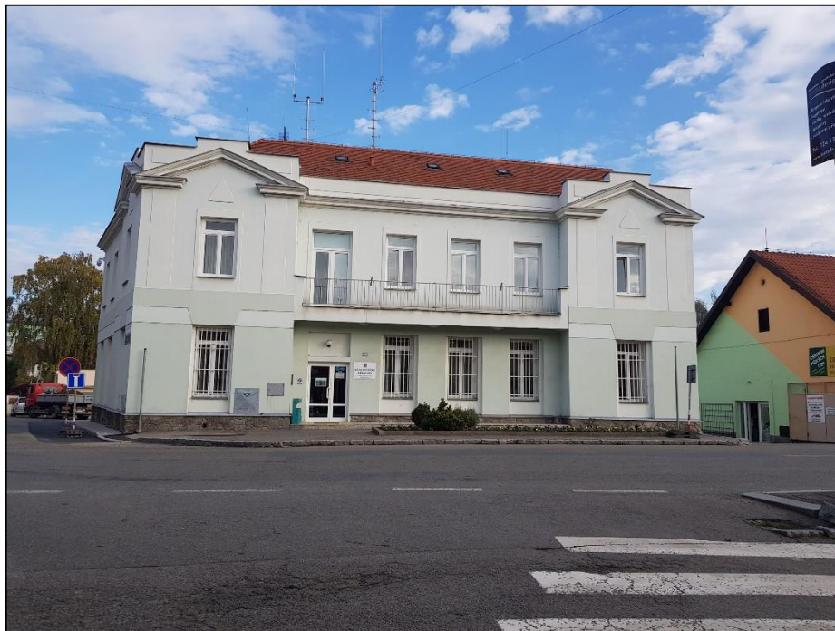
Obrázek 81 - Pohled na druhou budovu Městského úřadu Sedlčany, zdroj: autorka DP
