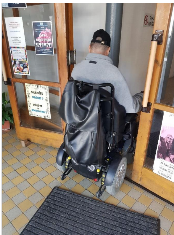
Obrázek 114 - Diagonálně otevřené dveře zádveří - pohled od vchodových dveří (pro osobu na vozíku komplikovaný vstup ze zádveří) zdroj: autorka DP
