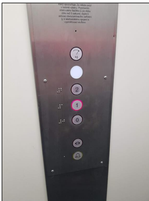
Obrázek 73 - Ovládací panel ve výtahu (nesprávné označení v Braillově písmu na levé straně od tlačítek), zdroj: autorka DP
