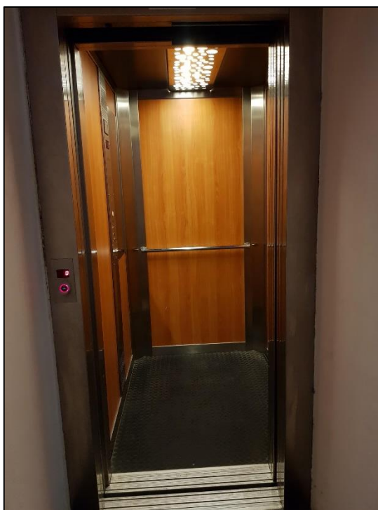
Obrázek 101 - Výtah v Budově MěÚ 3 (chybí zrcadlo a sedátko), zdroj: autorka DP
