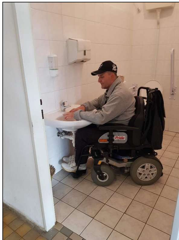
Obrázek 122 - Umyvadlo umožňuje podjezd osobě na vozíku (WC kabina 1.NP), zdroj: autorka DP
