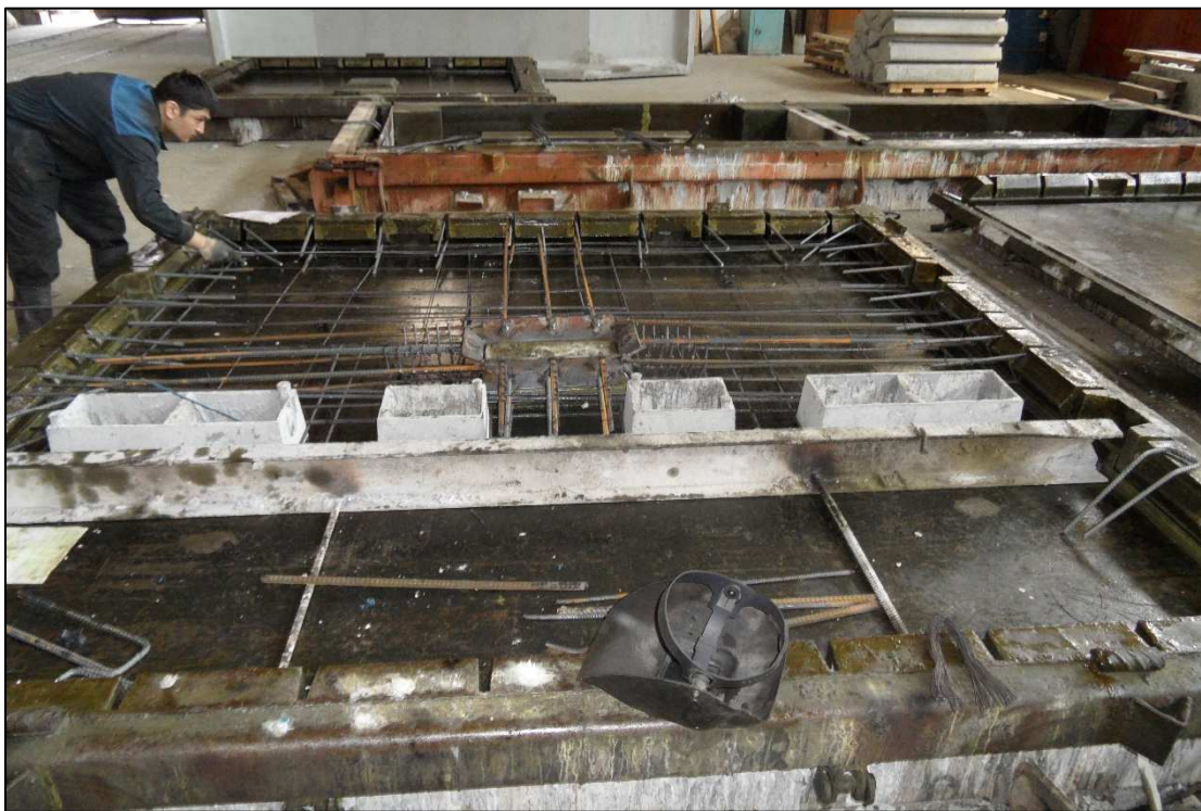
Obr. č. 17 – Snímek výroby nad sloupovou deskou. Proces výztužení.
