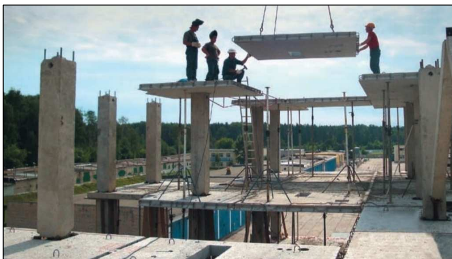
Obr. č.13 - Montážní práce mezi sloupové desky
